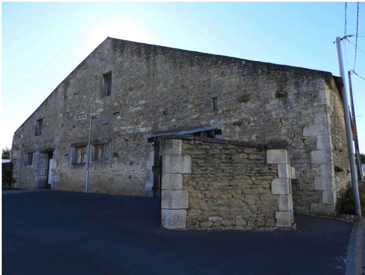
La grange-étable vue depuis le nord-ouest.
