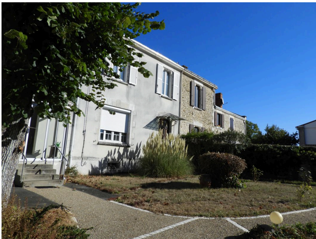
Le logis vu depuis le sud-ouest.
