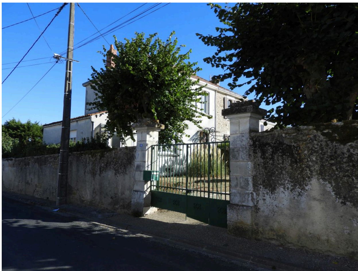
Le logis de ferme et son portail vus depuis le sud-ouest.
