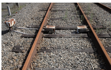
Pédales de réarmement, électromécaniques, PN 312, côté Nantes. Phot. Denis Pillet IVR52_20104402089NUCA
