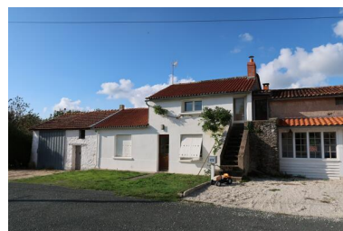
Vue de la rangée de fermes n°1 depuis le sud-est. Phot. Mathilde Vozza IVR52_20254900773NUCA
