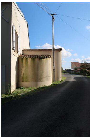
Rangée de fermes n°2. Détail d'un four à pain. Phot. Mathilde Vozza IVR52_20254900774NUCA
