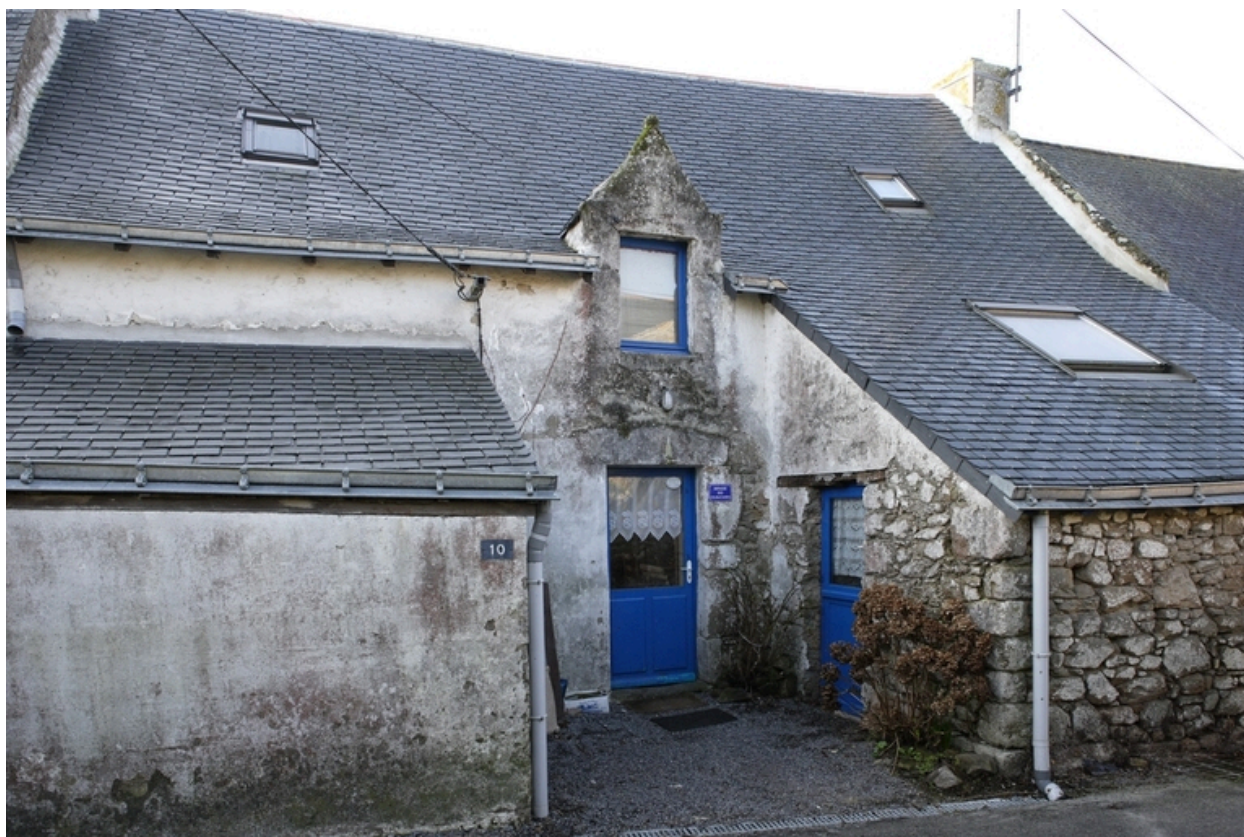
Vue du n° 10 rue du Rigouic.
