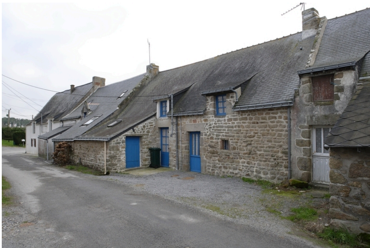
Vue du n° 8 rue du Rigouic.
