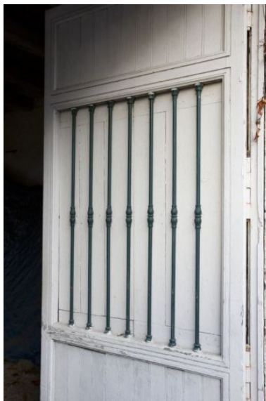
Le portail sur rue : détail. Phot. Yves Guillotin IVR52_20104403002NUCA
