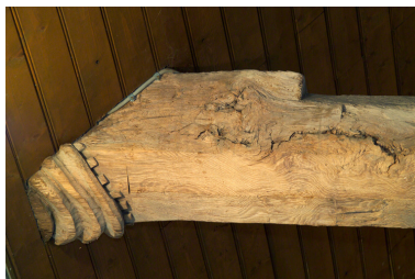
Charpente à engoulant (détail). Phot. Denis Pillet IVR52_20054402168NUCA
