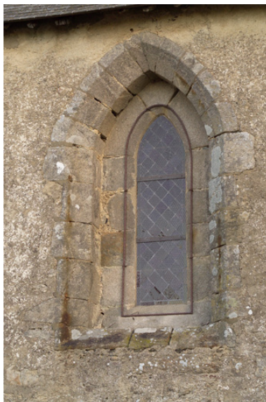
Fenêtre dans le mur sud, partie ouest. Phot. Denis Pillet IVR52_20054402172NUCA
