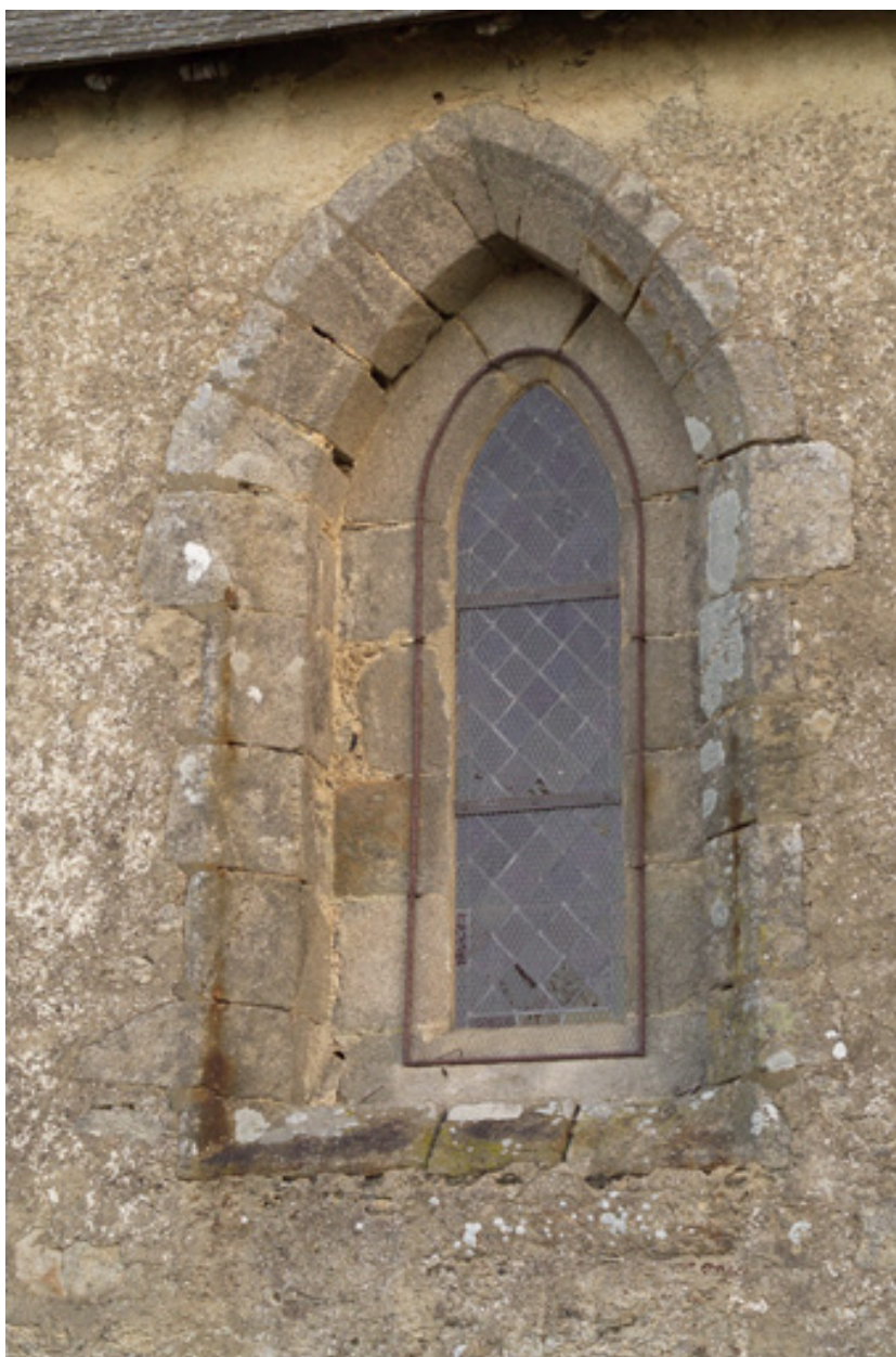
Fenêtre dans le mur sud, partie ouest.
