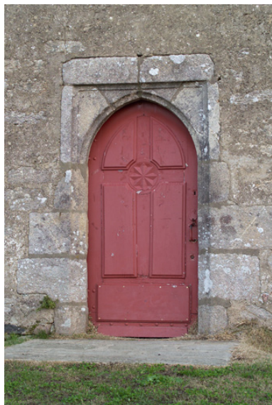
Porte dans le mur sud. Phot. Denis Pillet IVR52_20054402170NUCA
