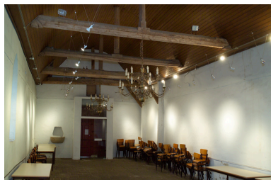
Intérieur de la nef vers le mur ouest. Phot. Denis Pillet IVR52_20054402166NUCA
