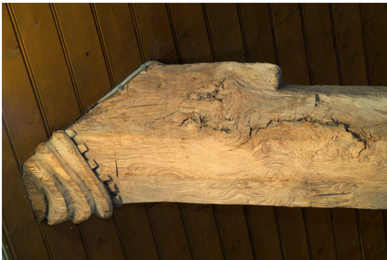
Charpente à engoulant (détail).
