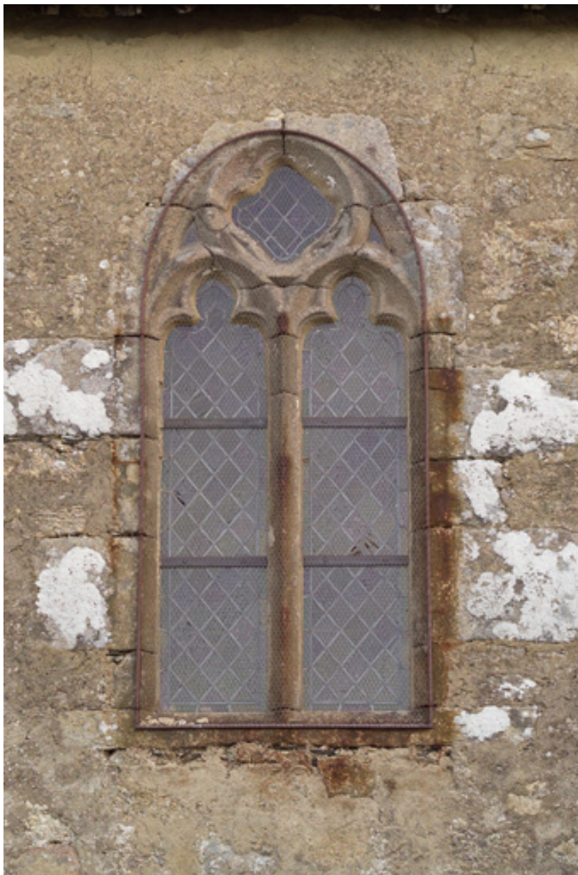
Baie dans le mur sud, partie est.
