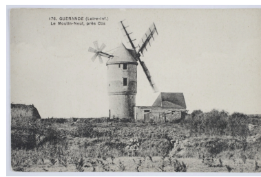
Le Moulin-Neuf, près de Clis, équipé de ses ailes Berton et de son moulinet d'orientation automatique. Photographie, carte postale, [s. n.], [1er quart XXe siècle]. Phot. Denis (reproduction) Pillet IVR52_20074401870NUCA
