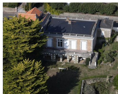
Vue aérienne de la villa Magdalena. Phot. Denis Pillet IVR52_20114401152NUCA
