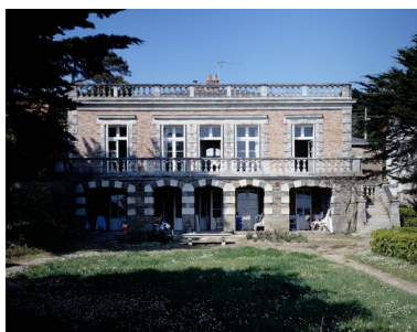
Villa Magdalena, élévation sud, face à la mer. Phot. Denis Pillet IVR52_19954400241VA
