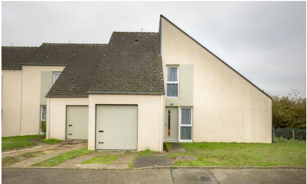
Vue de la façade principale d'une maison rue du Berry.
