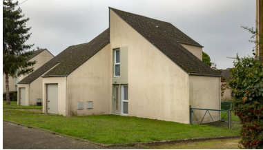
Vue d'une maison rue du Berry. Phot. Pierre-Bernard Fourny IVR52_20197202580NUCA
