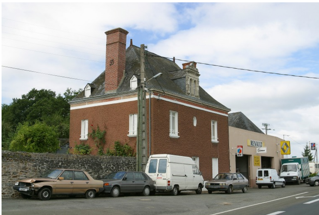
Le 7 rue du Petit Hasard vu depuis le nord-ouest : à gauche l'actuelle maison du propriétaire du garage ; à droite la maison transformée en garage.
