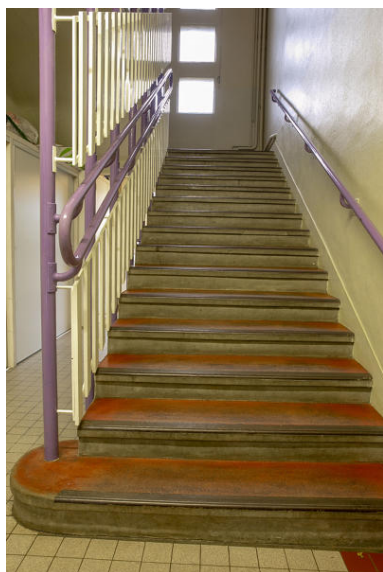
Vue de l'escalier principal de l'école depuis le rez-de-chaussée. Phot. Pierre-Bernard Fourny IVR52_20197202793NUCA
