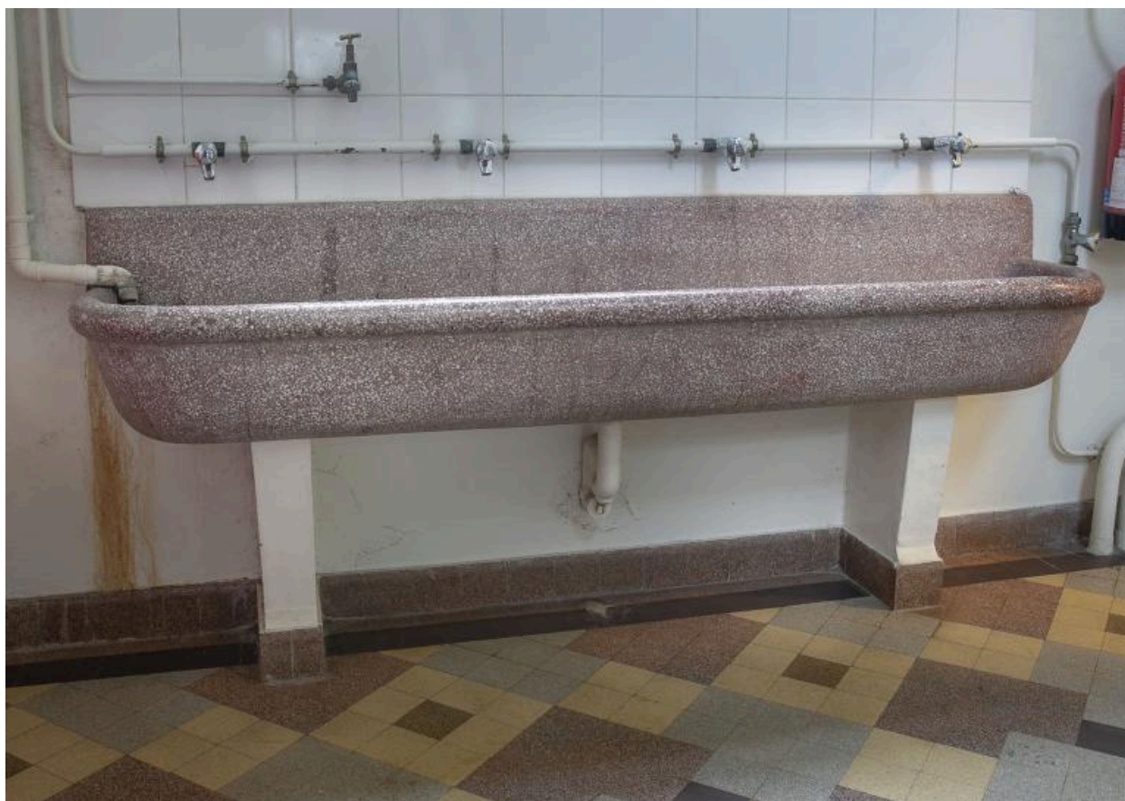
Vue du lavabo en granit au rez-de-chaussée du bâtiment 2 depuis la cage d'escalier
