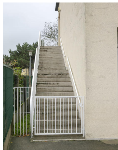
Vue de l'escalier extérieur menant au premier étage de l'école. Phot. Pierre-Bernard Fourny IVR52_20197202832NUCA
