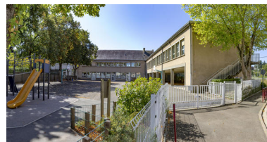
Vue de l'école donnant sur la cour depuis la rue Garnier Pagès. Phot. Pierre-Bernard Fourny IVR52_20197202163NUCA
