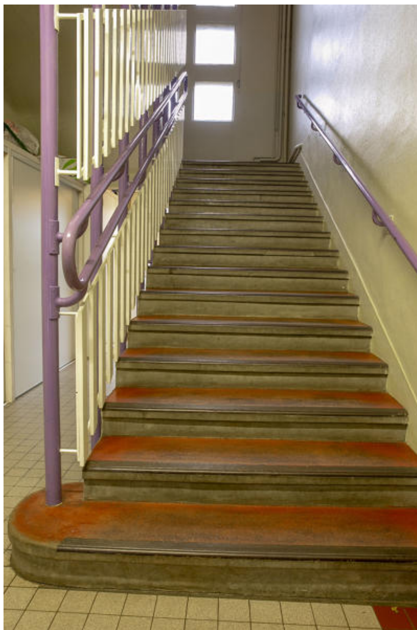
Vue de l'escalier principal de l'école depuis le rez-de-chaussée.
