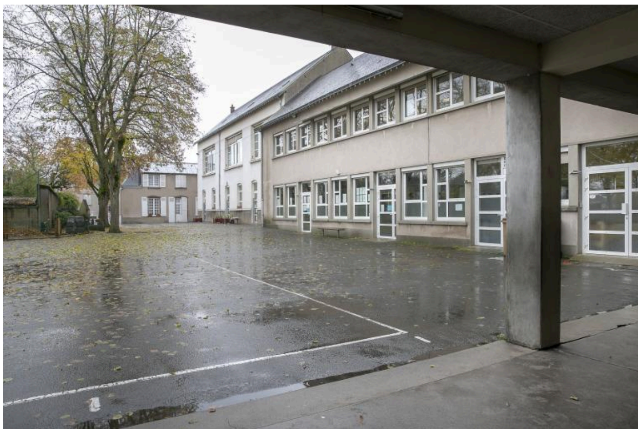
Vue de la cour de récréation avec les bâtiments 1, 2 et 3 depuis le préau du bâtiment 4
