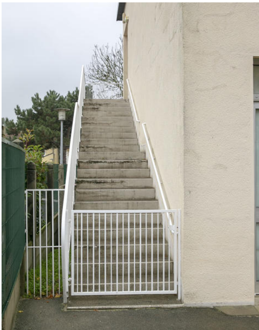
Vue de l'escalier extérieur menant au premier étage de l'école.
