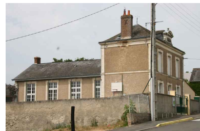
École des filles, vue de volume : logement du maître d'école et salle de classe en retour d'équerre. Phot. Jean-Baptiste Darrasse IVR52_20067206152NUCA
