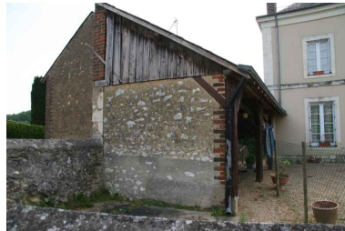
La Maison d'école de garçon : le préau. Phot. Jean-Baptiste Darrasse IVR52_20067206139NUCA
