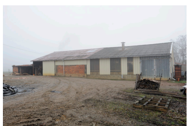
Façade nord-est de la Tuilerie-briqueterie Caillet. Phot. Bruno Rousseau IVR52_20114900309NUCA
