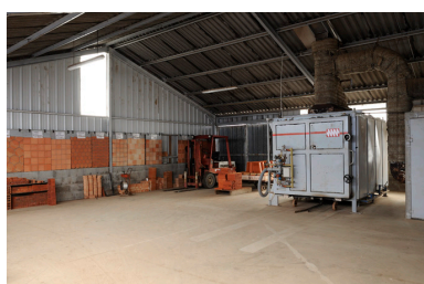
Pièce de stockage et four à gaz. Phot. Bruno Rousseau
