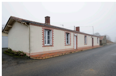
Maisons de la famille Caillet, situées en bordure de route. Phot. Bruno Rousseau IVR52_20114900335NUCA
