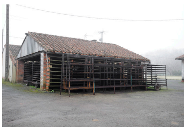
Dépendance pour stocker les chariots utilisés pour le séchage de la production. Phot. Bruno Rousseau IVR52_20114900332NUCA
