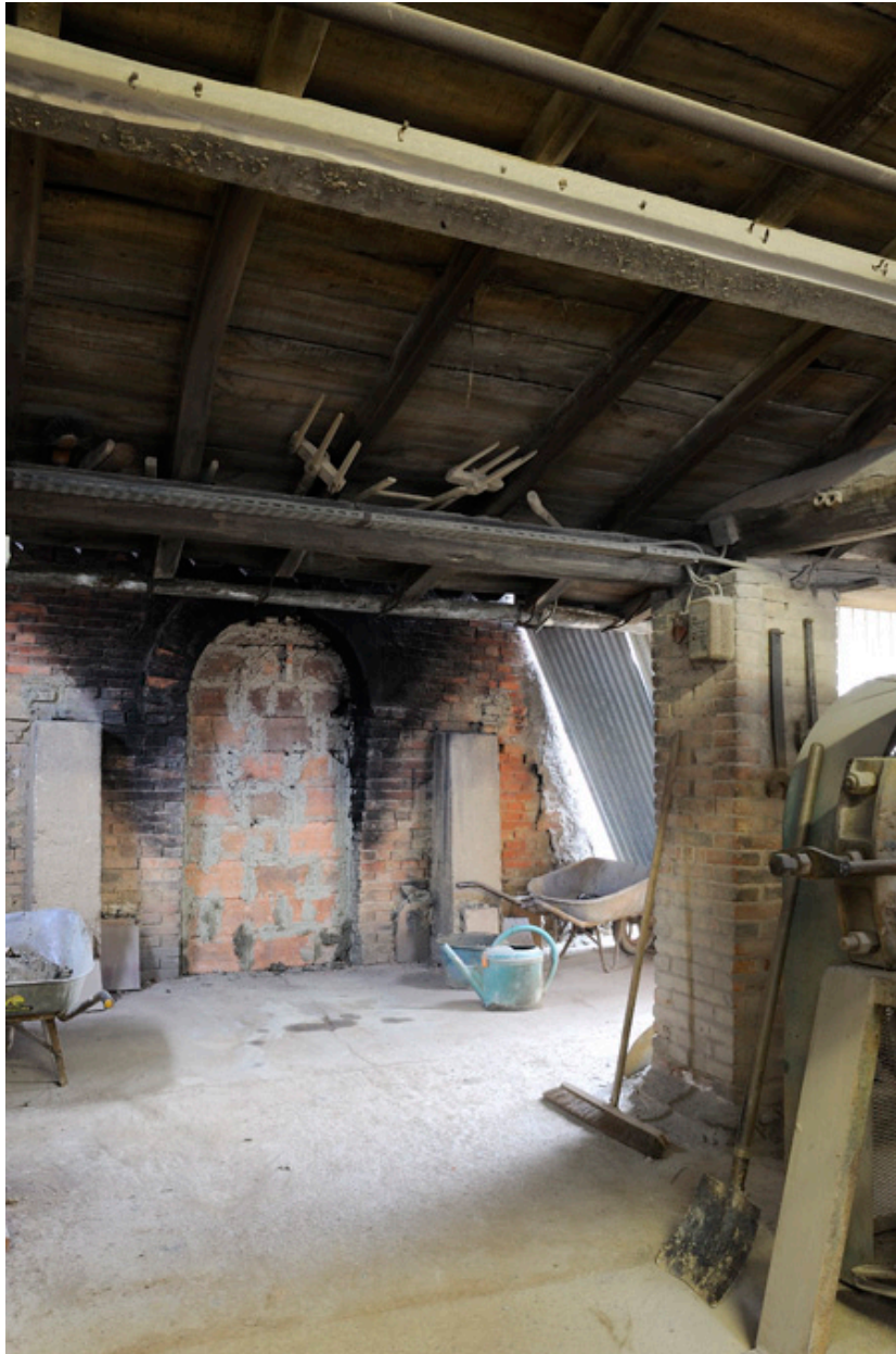
Porte du four à bois murée après chargement des tuiles et des briques.
