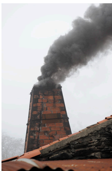
Cheminée du four à bois. Phot. Bruno Rousseau IVR52_20114900303NUCA
