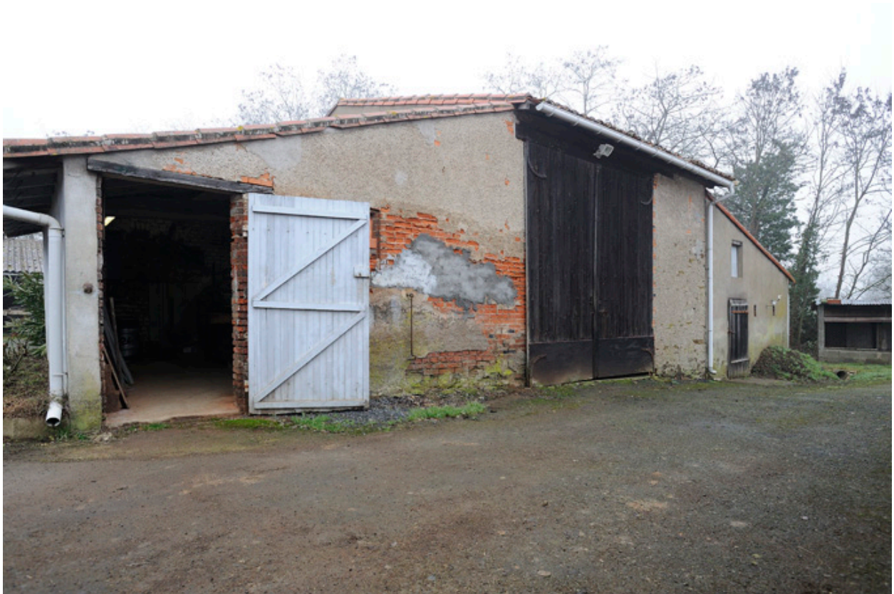
Grange-étable, située au nord-ouest de la cour.
