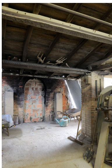
Porte du four à bois murée après chargement des tuiles et des briques. Phot. Bruno Rousseau IVR52_20114900323NUCA
