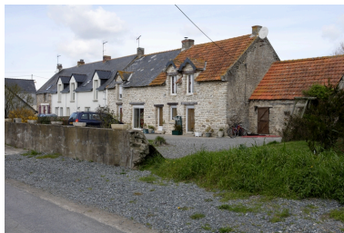
Vue d'ensemble de la rangée depuis le sud-est. Phot. Denis Pillet IVR52_20084400553NUCA
