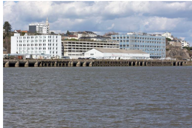
Moulins, vue de la Loire. Phot. Denis Pillet IVR52_20134401305NUCA
