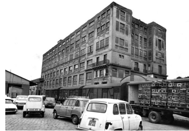
Vue des façades sud et est de la minoterie sur le Quai Saint-Louis, sans date. IVR52_20134400882NUCA
