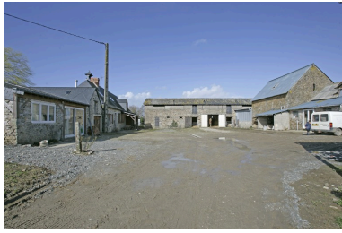
Vue d'ensemble des bâtiments de la ferme depuis le sud : le logis, l'étable-grange, l'étable à chevaux. Phot. François Lasa IVR52_20075301427NUCA
