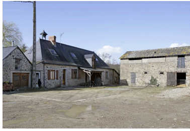
Le logis et l'étable-grange vus depuis la cour au sud-est. Phot. François Lasa IVR52_20075301428NUCA
