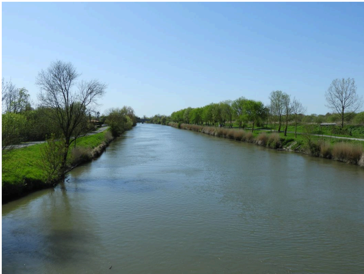
Le canal vu en direction de l'ouest depuis le pont de L'Île-d'Elle.
