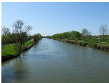
Le canal vu en direction de l'ouest depuis le pont de L'Île-d'Elle.
