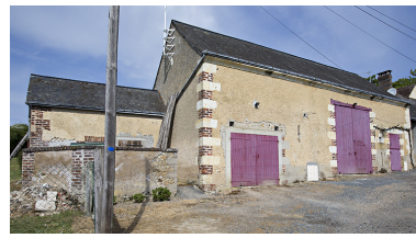
Toit à porcs et grange-étable. Phot. Pierre-Bernard Fourny IVR52_20147200201NUCA
