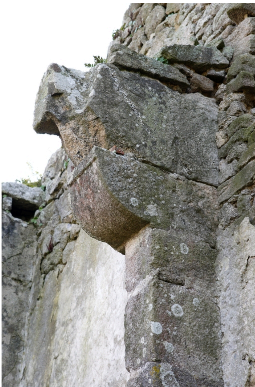
Détail du corbeau de la cheminée de la cheminée de l'étage du deuxième logis.
