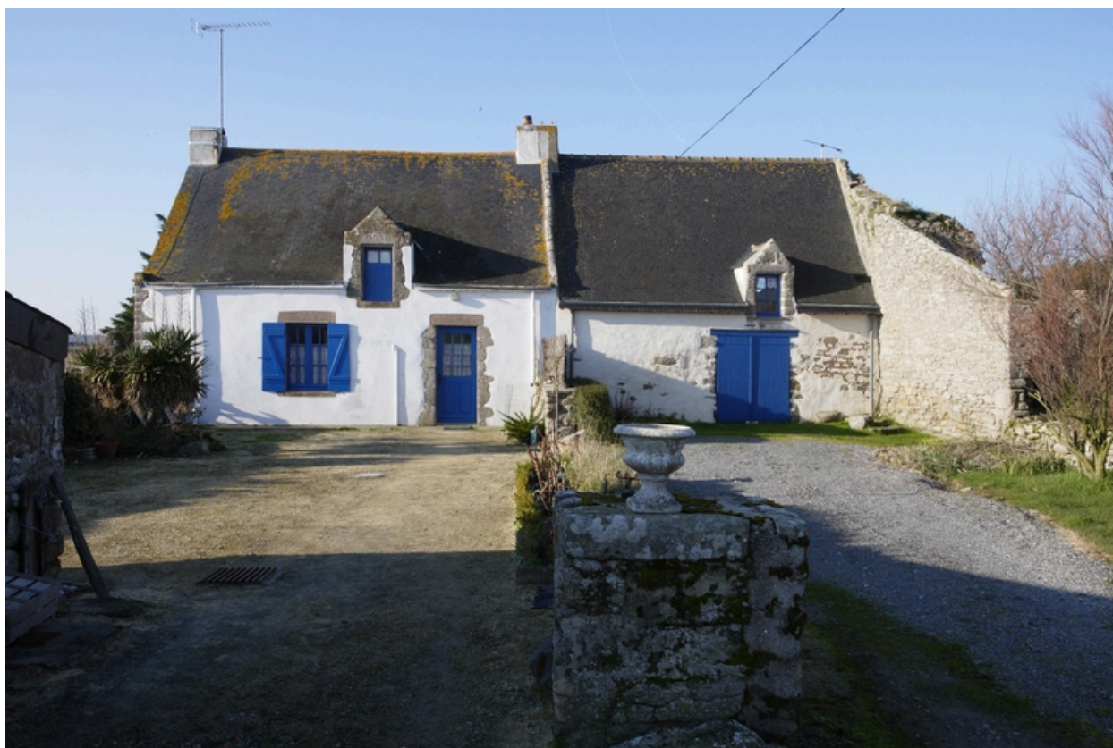
Vue des deuxième et troisième logis de la rangée.
