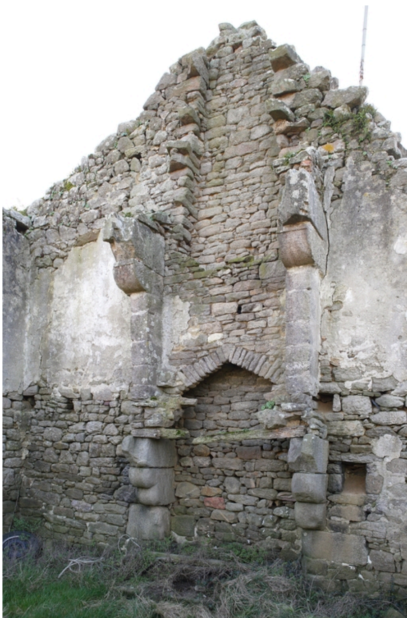
Vue des cheminées superposées du deuxième logis.
