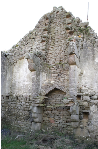
Vue des cheminées superposées du deuxième logis. Phot. Denis Pillet IVR52_20084400134NUCA
