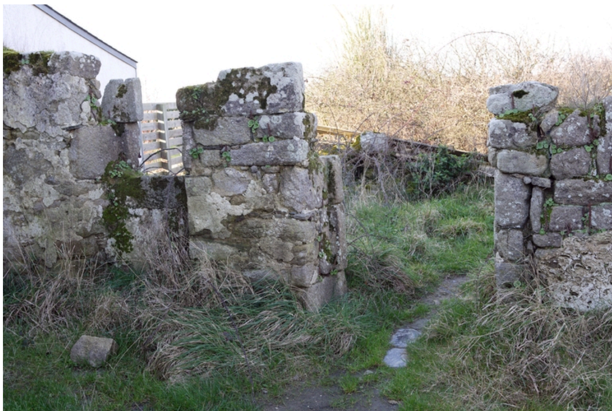
Détail de l'embrasure de la porte et de la fenêtre sud du deuxième logis.
