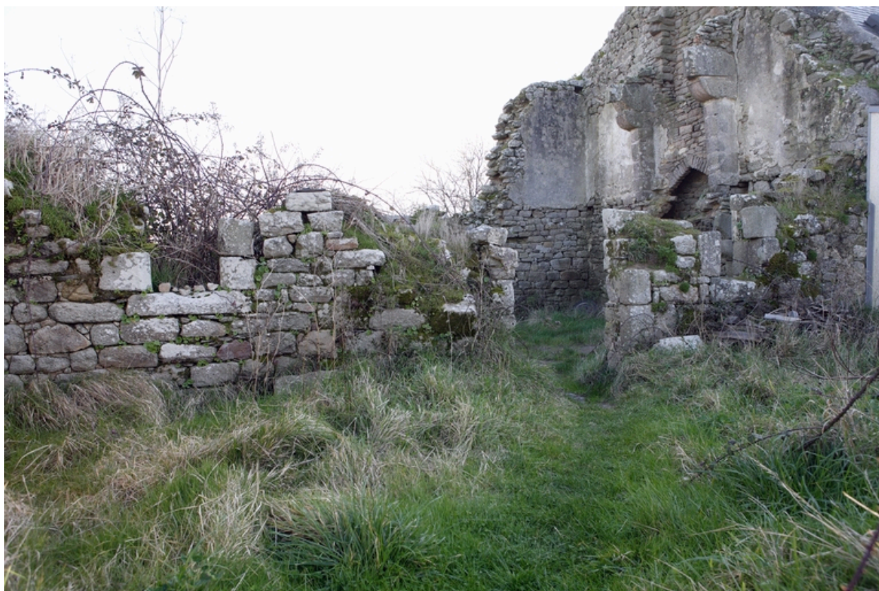
Vue d'ensemble de la façade sud du deuxième logis.
