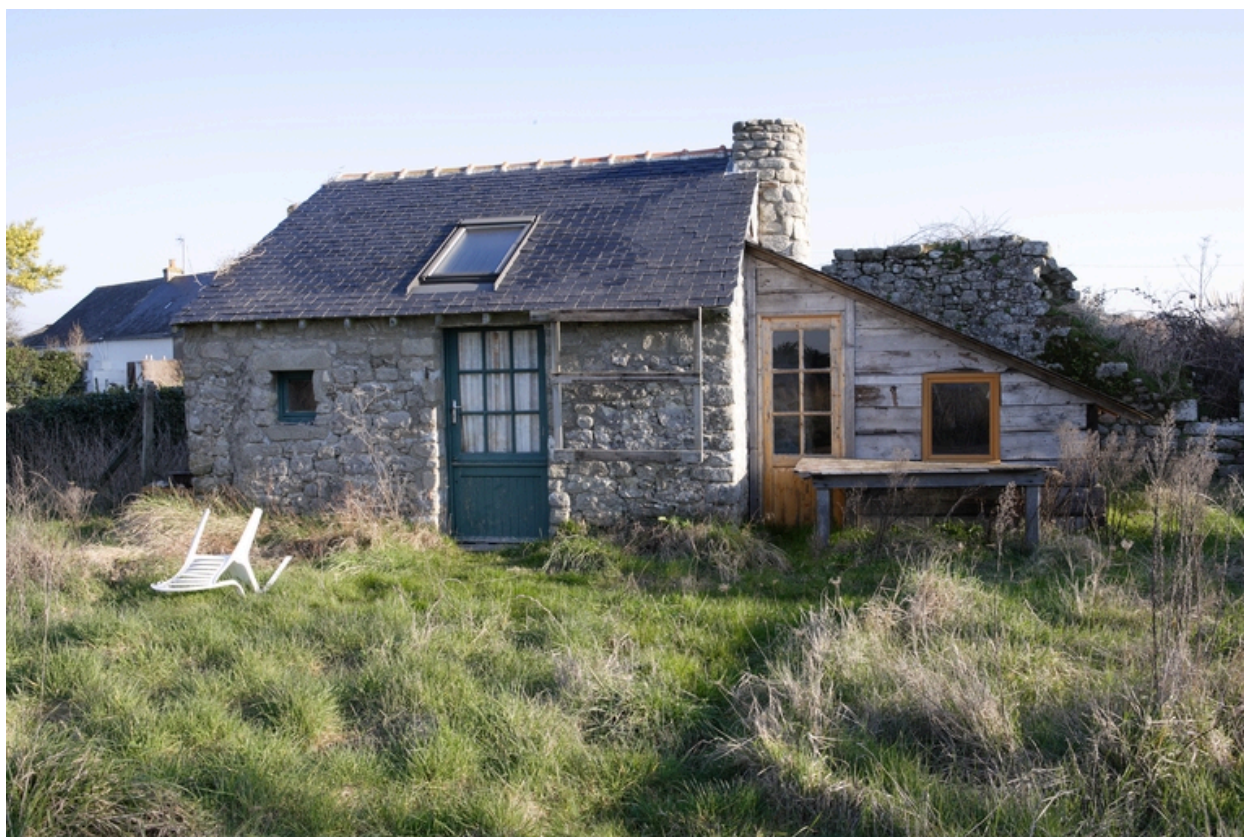
Vue du fournil depuis le sud.
