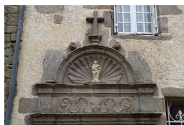
Façade sud, porte centrale : détail de la partie haute. Phot. Denis Pillet IVR52_20054402367NUCA
