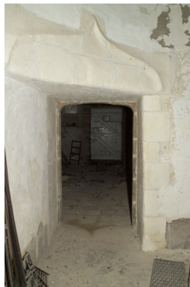
Escalier en vis, rez-de-chaussée, revers de la porte d'accès. Phot. Denis Pillet IVR52_20054402355NUCA
