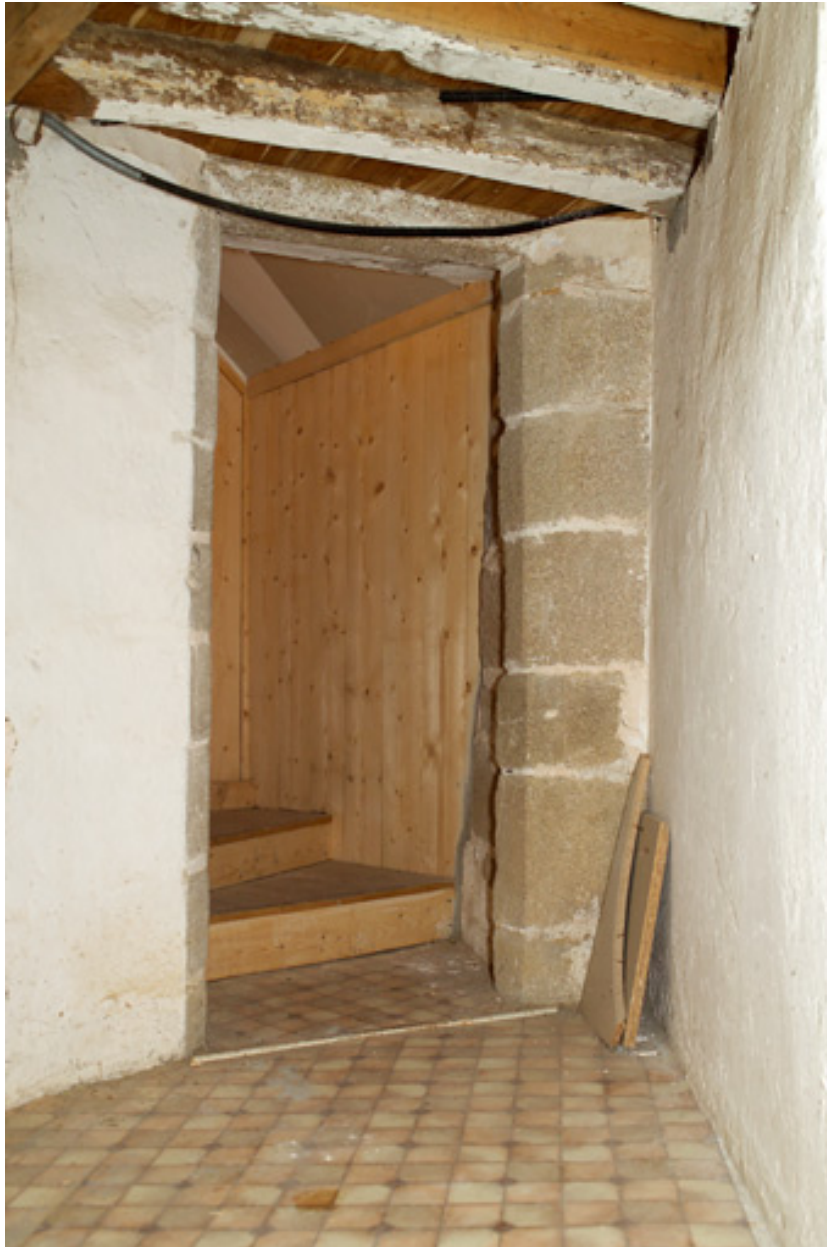
Escalier en vis, ouverture vers le comble.
