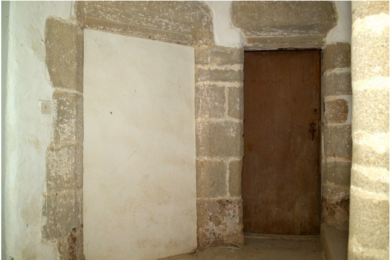
Escalier en vis, palier de l'étage, portes centrale et occidentale.
