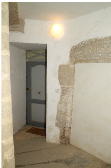
Escalier en vis, palier de l'étage, portes orientale et centrale.
