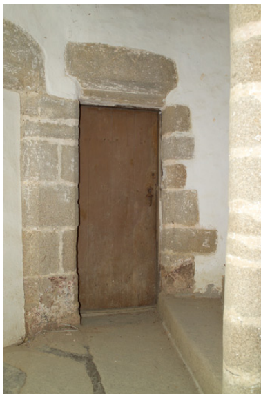
Escalier en vis, palier de l'étage, détail de la porte occidentale. Phot. Denis Pillet IVR52_20054402357NUCA
