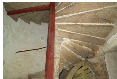
Escalier en vis, rez-de-chaussée, détail. Phot. Denis Pillet IVR52_20054402349NUCA
