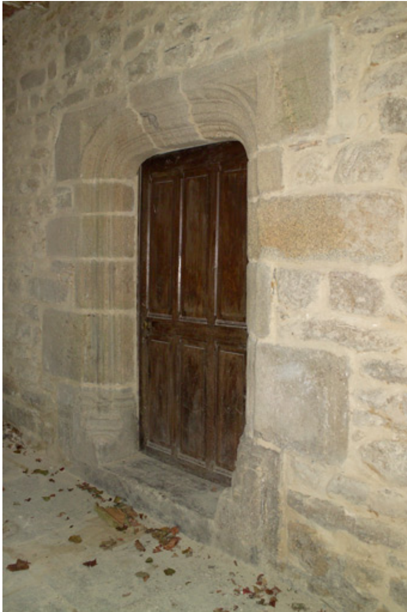
Rez-de-chaussée, couloir de distribution, porte vers la pièce ouest.
