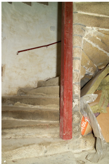
Escalier en vis, rez-de-chaussée, détail. Phot. Denis Pillet IVR52_20054402348NUCA
