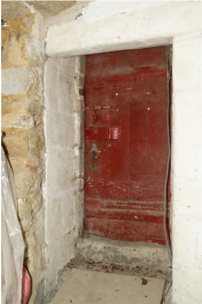
Escalier en vis, rez-de-chaussée, porte nord.
