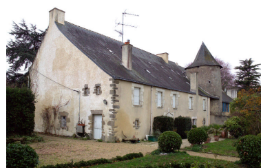
Vue générale du pignon est et de la façade nord. Phot. Denis Pillet IVR52_20054402372NUCA
