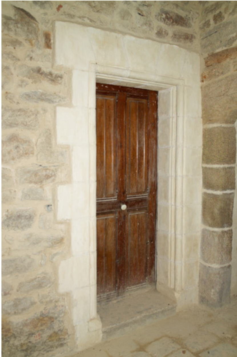
Rez-de-chaussée, couloir de distribution, porte ouest vers le couloir de distribution longitudinal.
