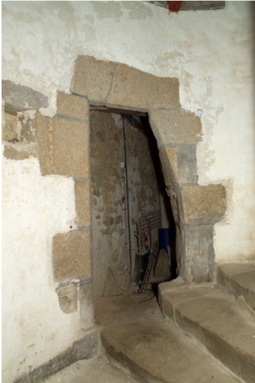
Escalier en vis, rez-de-chaussée, entrée d'une annexe.
