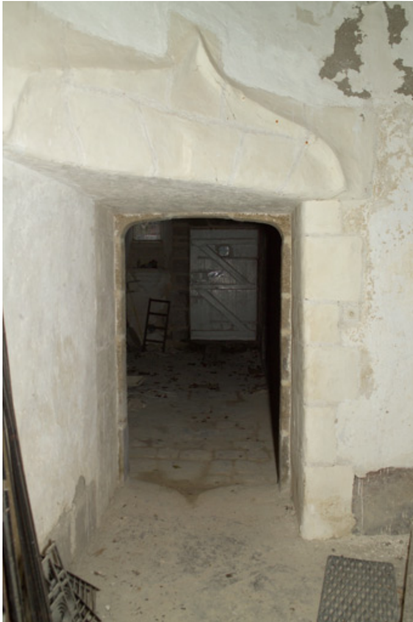
Escalier en vis, rez-de-chaussée, revers de la porte d'accès.
