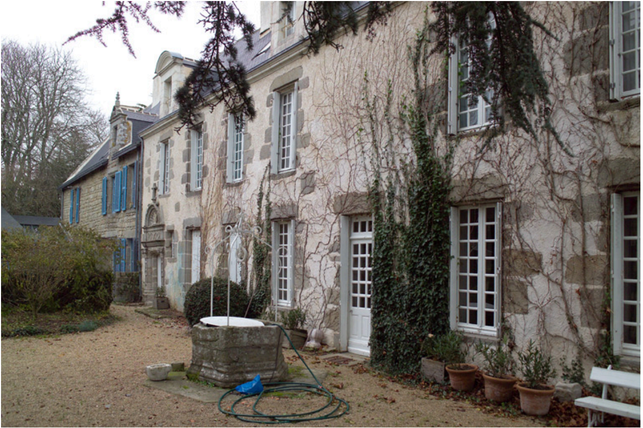
Vue générale de la façade sud.
