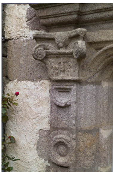
Façade sud ; porte centrale, détail du montant gauche. Phot. Denis Pillet IVR52_20054402368NUCA
