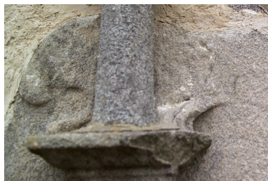
Façade sud, porte centrale : détail de la partie sommitale. Phot. Denis Pillet IVR52_20054402365NUCA
