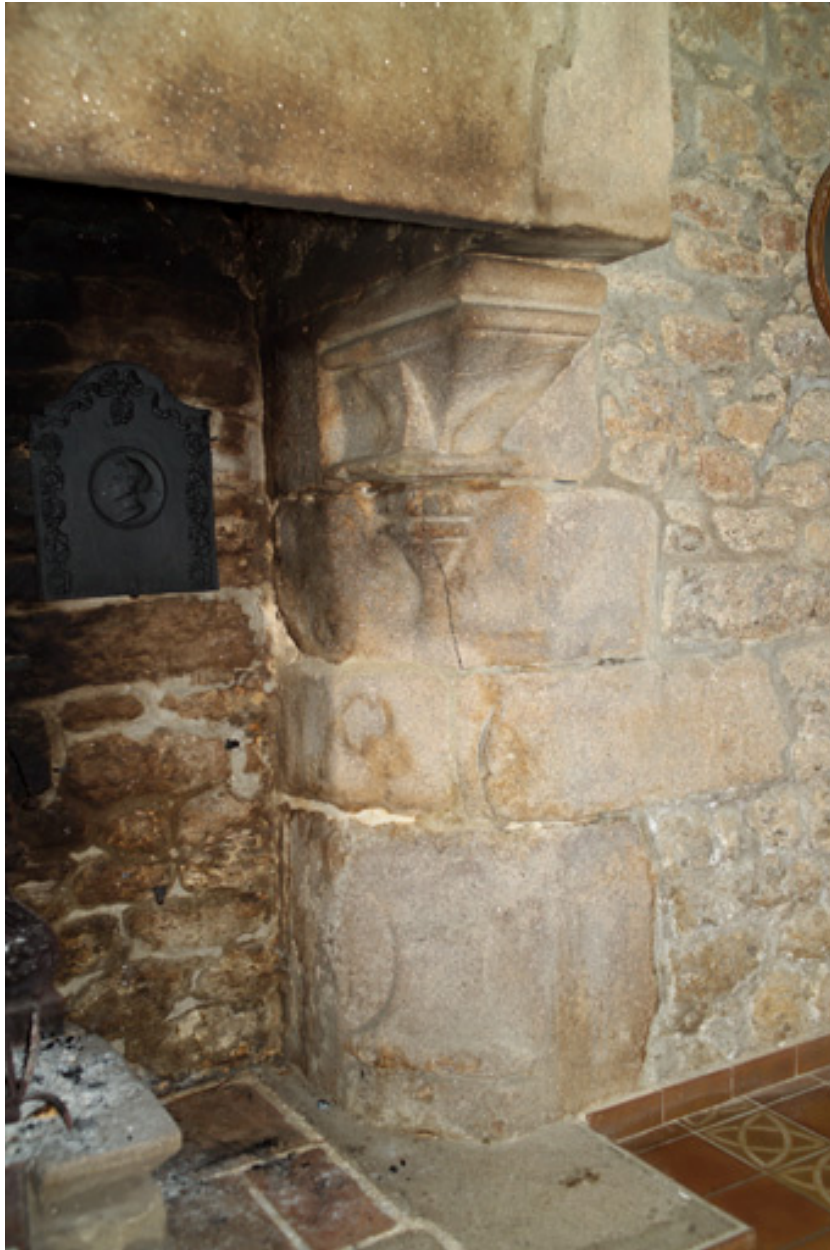
Rez-de-chaussée oriental, cheminée sur le mur est, détail du montant droit.
