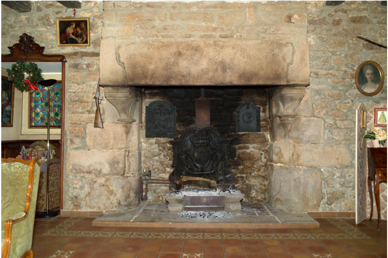
Rez-de-chaussée oriental, cheminée sur le pignon est.
