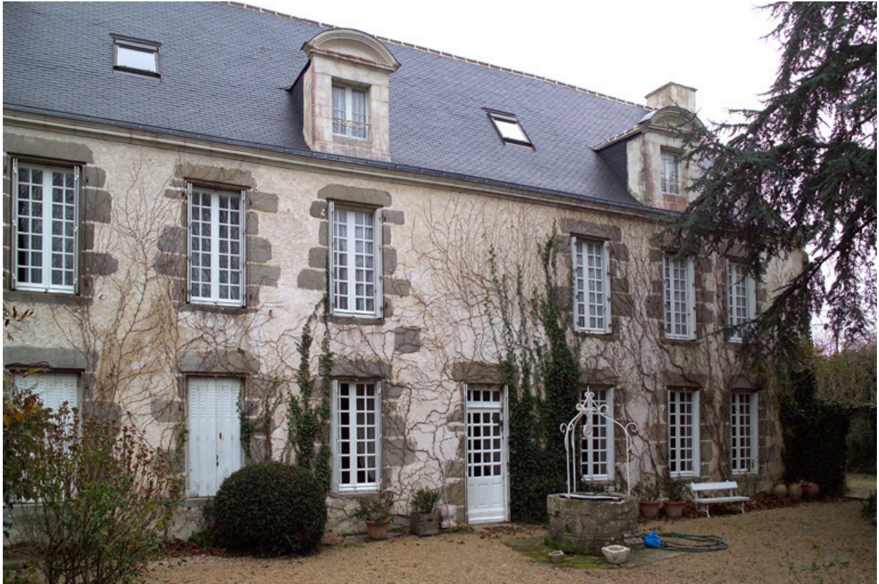
Vue de la façade sud ; portion orientale.
