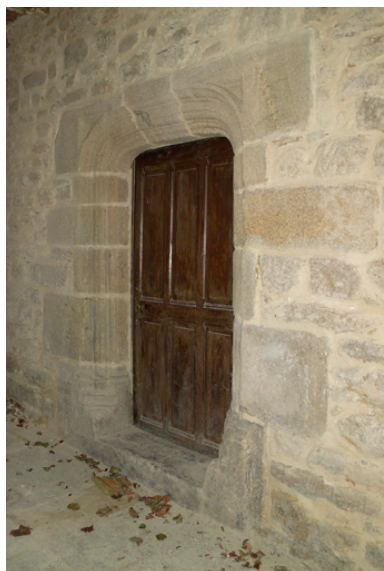
Rez-de-chaussée, couloir de distribution, porte vers la pièce ouest. Phot. Denis Pillet IVR52_20054402351NUCA
