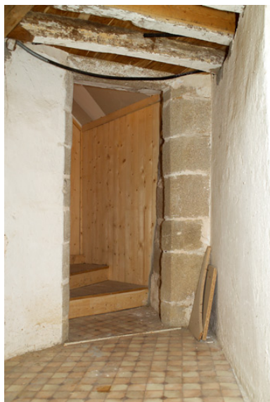
Escalier en vis, ouverture vers le comble. Phot. Denis Pillet IVR52_20054402363NUCA
