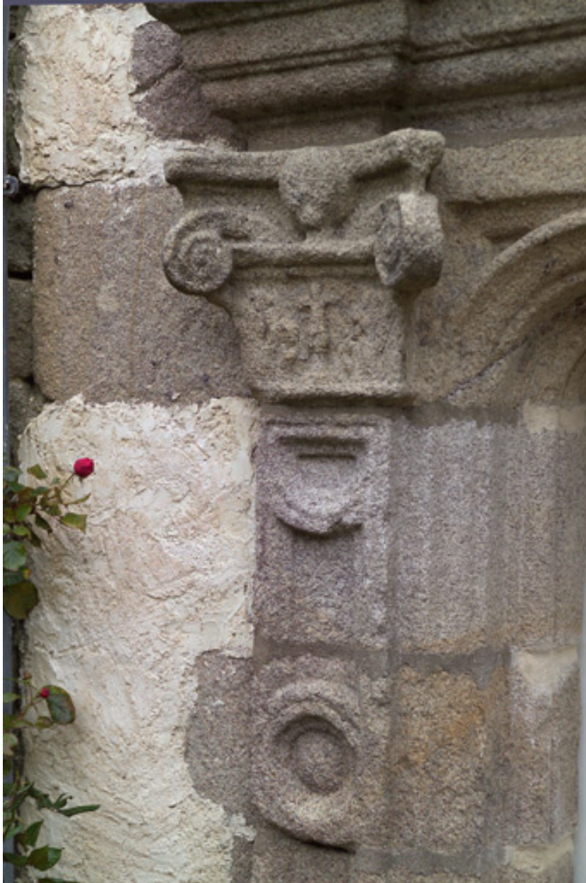
Façade sud ; porte centrale, détail du montant gauche.
