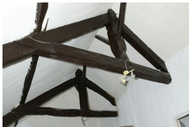
Vue de la charpente. Phot. Denis Pillet IVR52_20074400907NUCA
