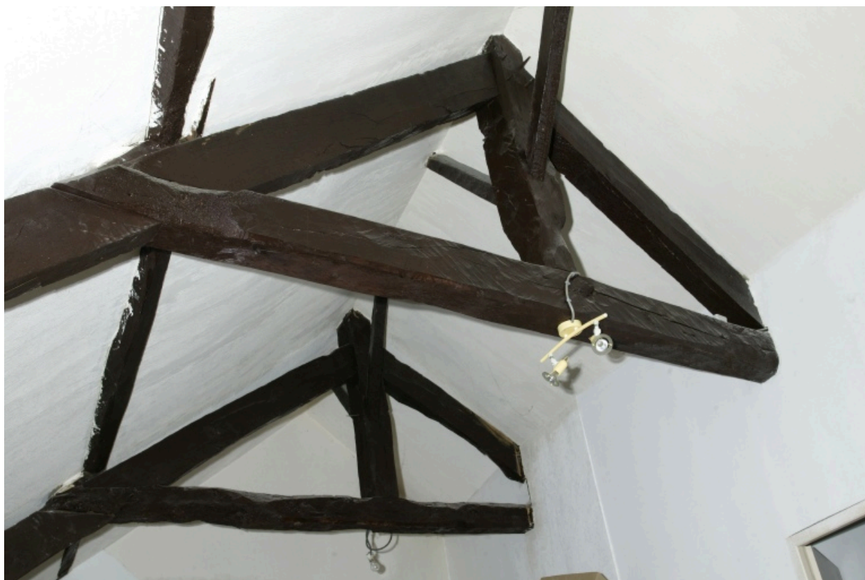
Vue de la charpente.
