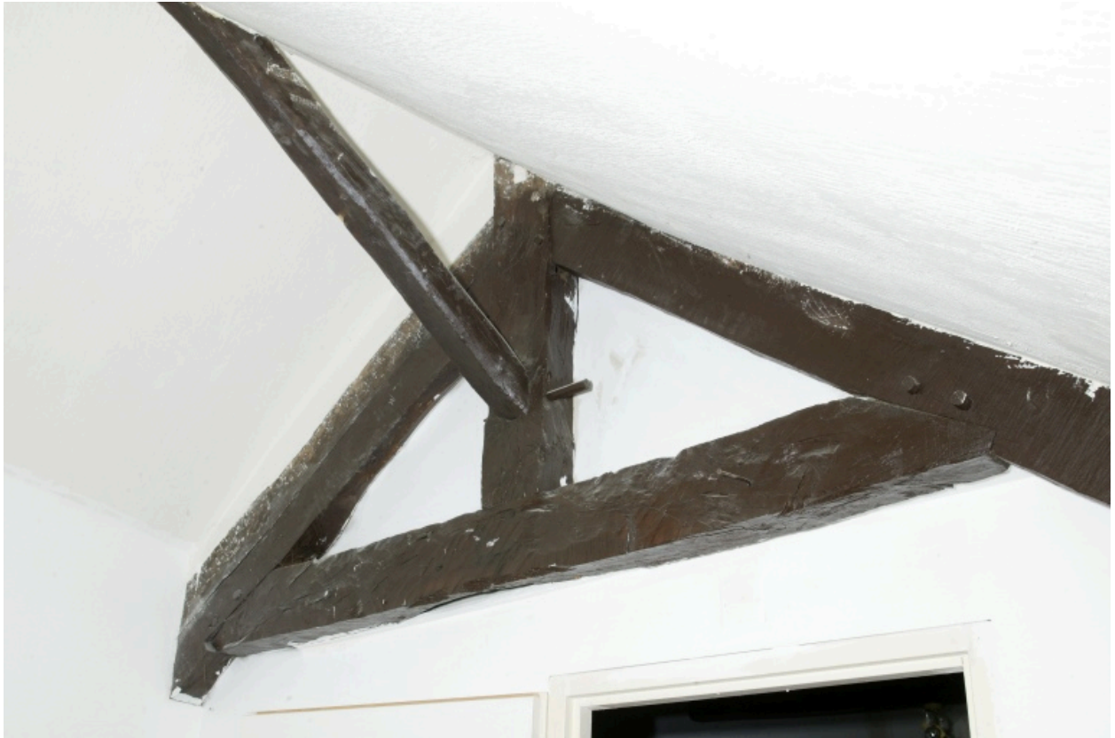
Détail d'une ferme de charpente.
