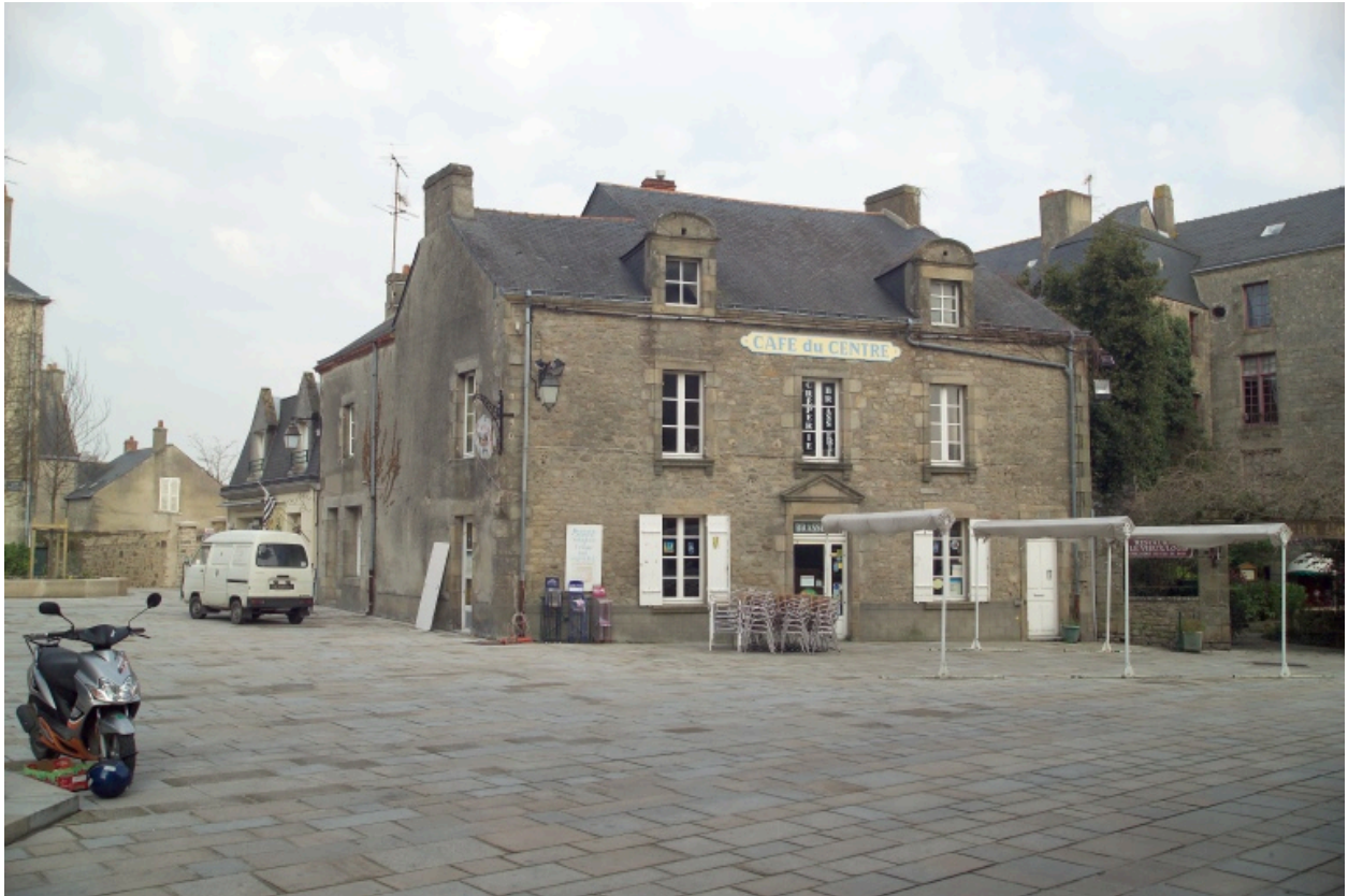
Vue générale vers le Nord-Ouest.
