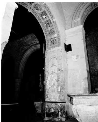
Intrados, partie nord. Phot. Patrice Giraud IVR52_19924900887X
