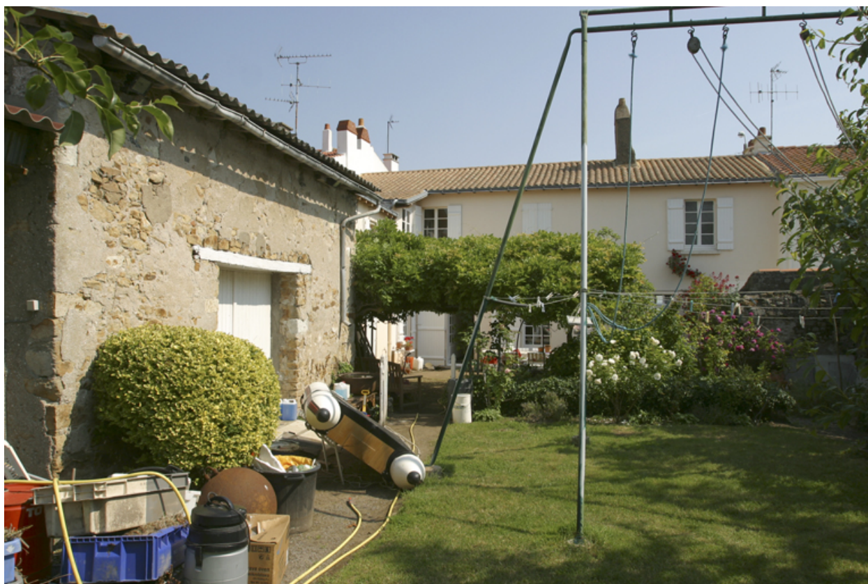
La façade postérieure vue depuis le jardin.
