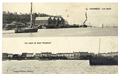
Vue d'ensemble du quai Libert (1ère moitié XXe siècle). Autr. Artaud-Nozais, Phot. Denis (reproduction) Pillet IVR52_20034401766NUCA
