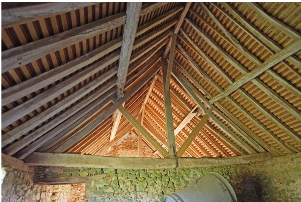
La charpente vue depuis le nord.
