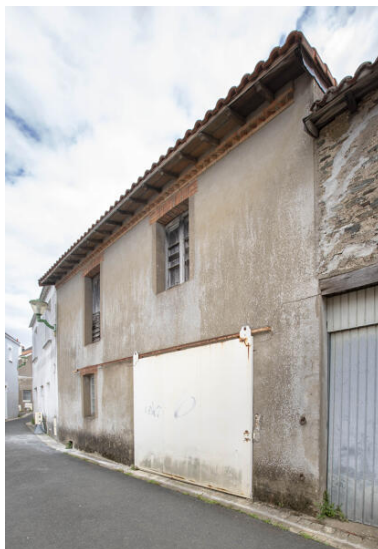
Porte sur rail au négoce Nicolon, rue Traversière, Vertou. Phot. Pierre-Bernard Fourny IVR52_20224400348NUCA
