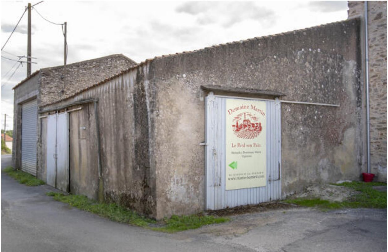
Portes sur rail au négoce Boutin, la Hautière, Saint-Fiacre-sur-Maine.
