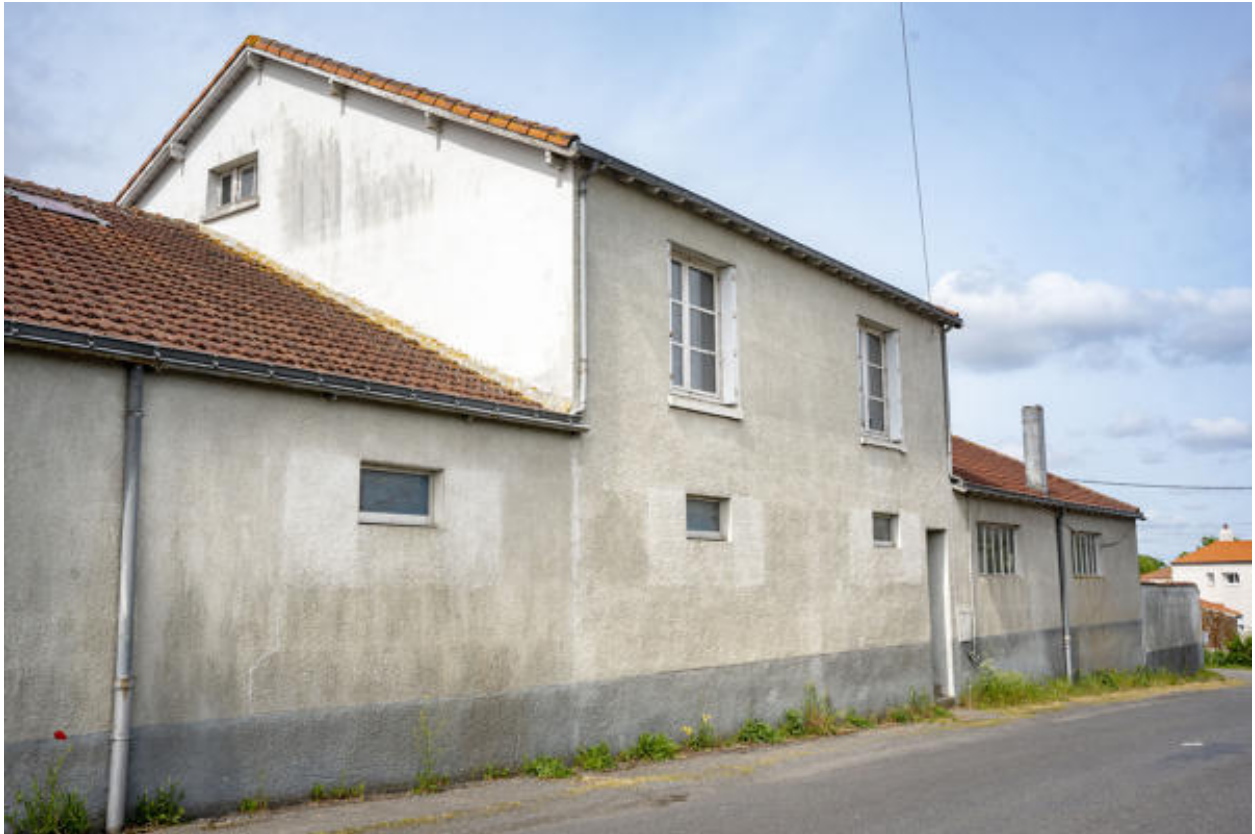
Les établissements Guéry (puis Perraud), détail de l'habitation, La Chapelle-Heulin.
