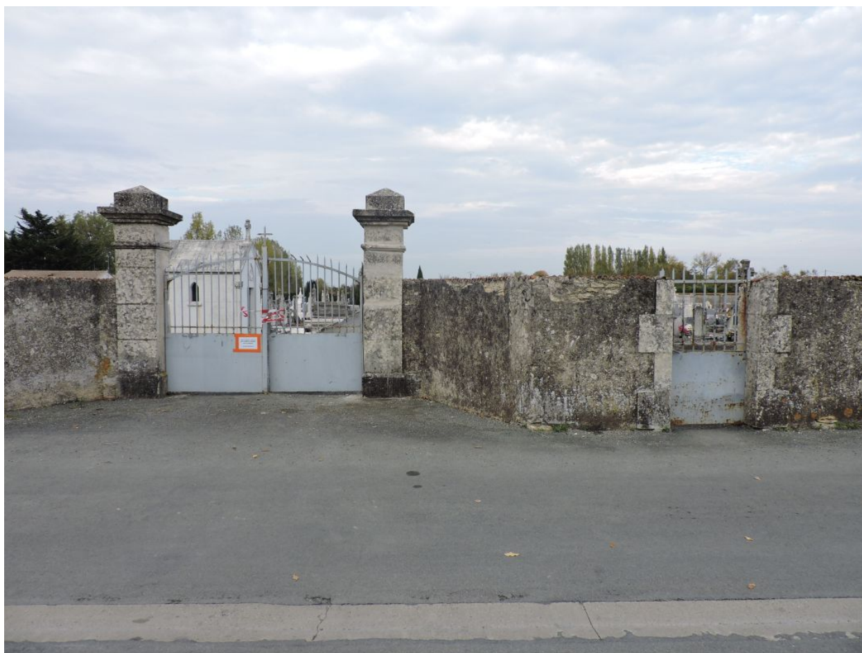
Le portail et la porte piétonne dans le mur sud.
