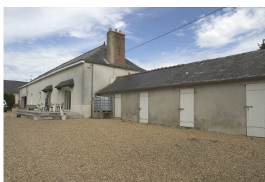
Vue d'ensemble depuis le sud-est. Phot. François Lasa IVR52_20045302174NUCA
