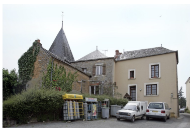
La façade postérieure de la maison et la dépendance vues depuis la rue des Molaines au nord-est (à gauche). Phot. François Lasa IVR52_20075302184NUCA
