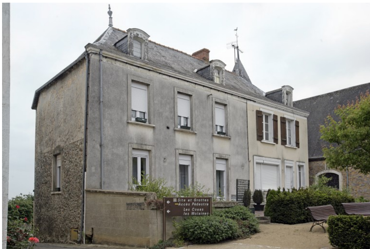
La façade antérieure vue depuis l'ouest (à droite).
