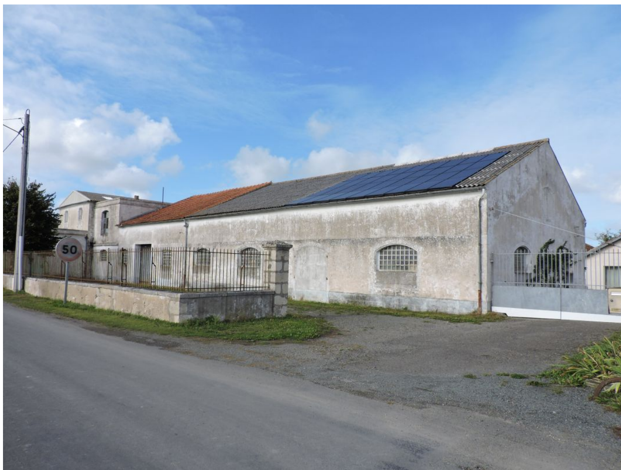
L'ancienne laiterie vue depuis le sud-est.
