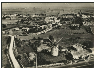
La laiterie, en haut à droite, avec sa cheminée, sur une vue aérienne vers 1960. Repro. Yannis Suire IVR52_20188501097NUCA
