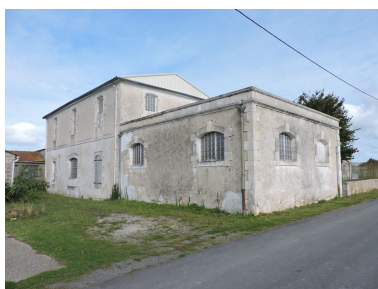
Le corps de bâtiment à toit en terrasse et celui à un étage, à l'ouest de l'ensemble, vus depuis le sud-ouest. Phot. Yannis Suire IVR52_20188500689NUCA
