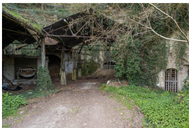
Entrée nord. Phot. Jeanne Minier IVR52_20267200369NUCA
