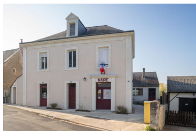
Vue d'ensemble depuis la rue de la Petite Fontaine. Phot. Jeanne Minier IVR52_20257200671NUCA
