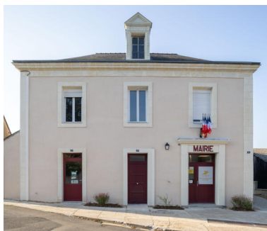
Façade de la mairie. Phot. Jeanne Minier IVR52_20257200670NUCA
