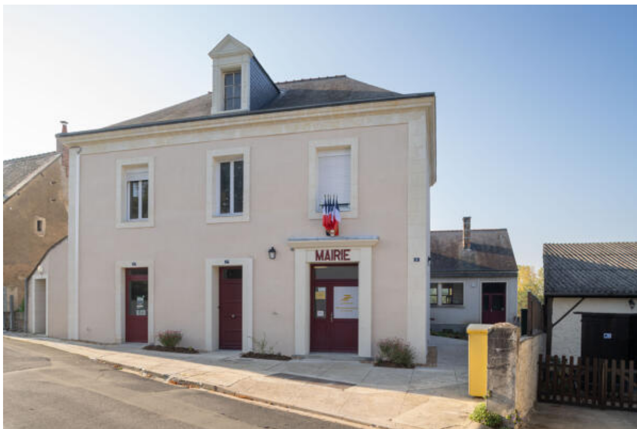
Vue d'ensemble depuis la rue de la Petite Fontaine.
