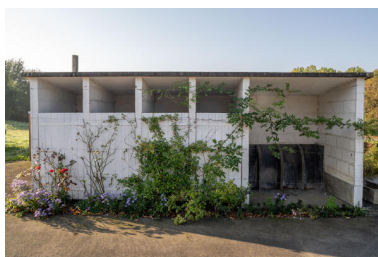
Toilettes extérieures. Phot. Jeanne Minier IVR52_20257200673NUCA
