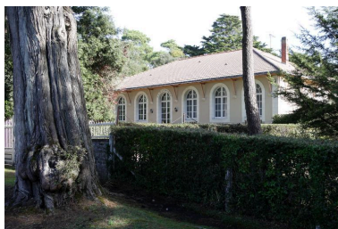
Élévation antérieure de La Sapinière. Phot. Denis Pillet IVR52_20094401301NUCA
