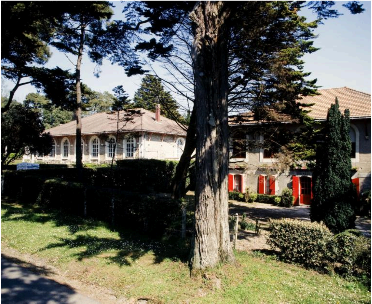
Vue d'ensemble, depuis la rue.
