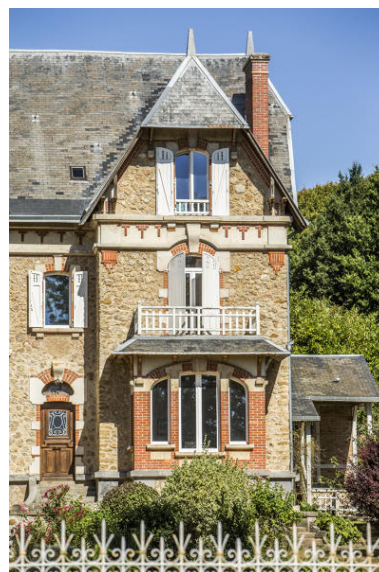
Un détail de l'avant-corps. Phot. Pierre-Bernard Fourny IVR52_20207200739NUCA
