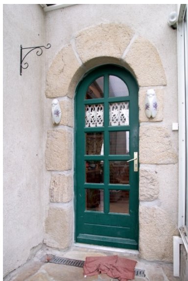
Porte sur la façade postérieure. Phot. Denis Pillet IVR52_20074400136NUCA
