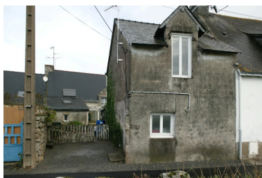
Vue de la façade postérieure et du bâtiment cadastré AH 199. Phot. Denis Pillet IVR52_20064403128NUCA
