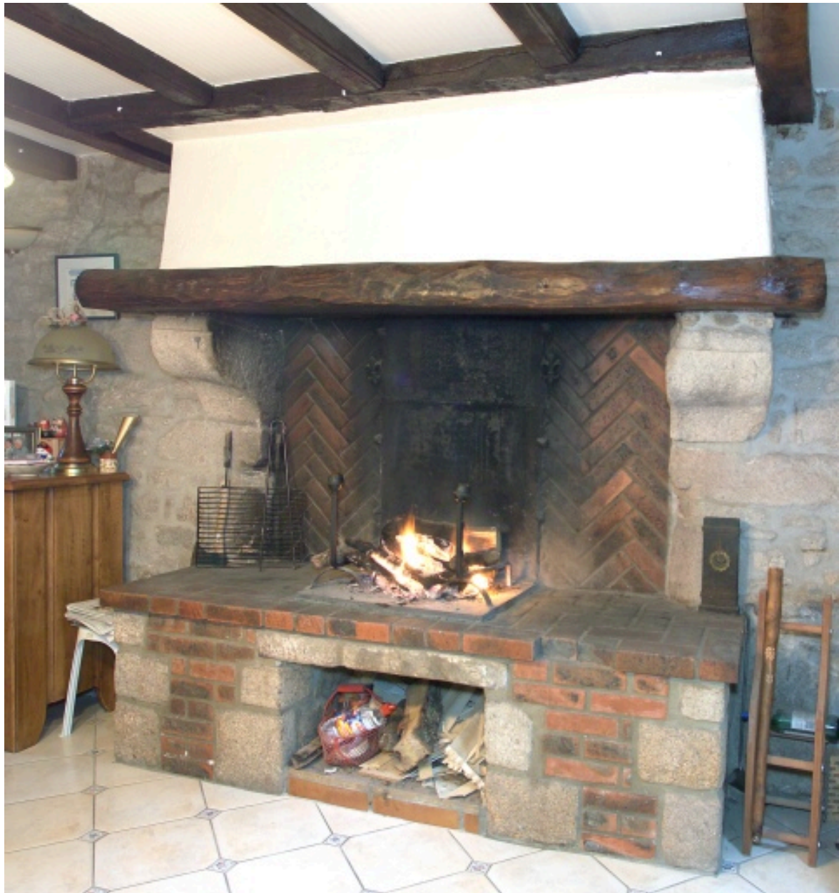
Vue de la cheminée.
