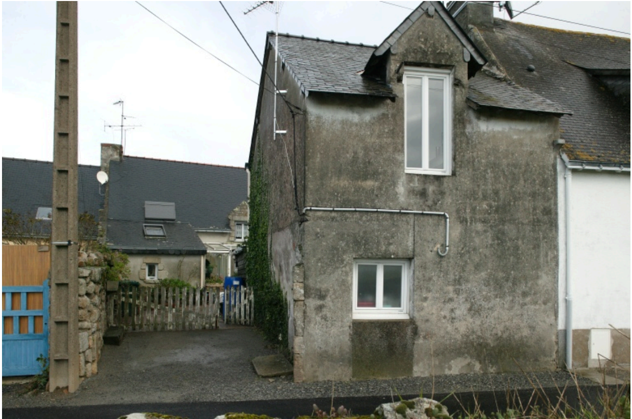
Vue de la façade postérieure et du bâtiment cadastré AH 199.
