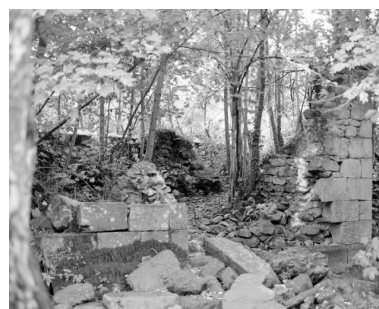
Les vestiges de la façade ouest du moulin des Communes.
