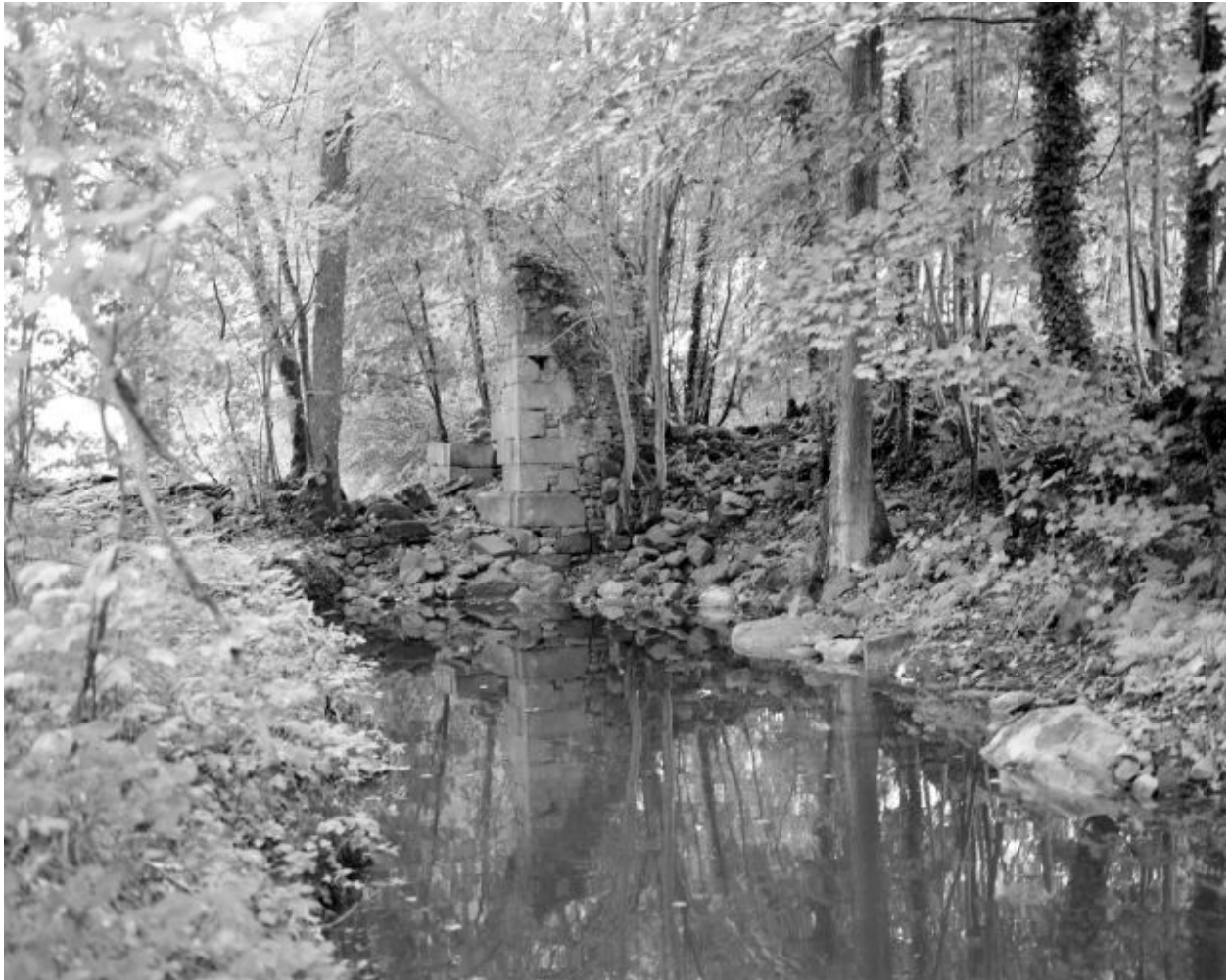
Les vestiges du moulin des Communes vus du sud.
