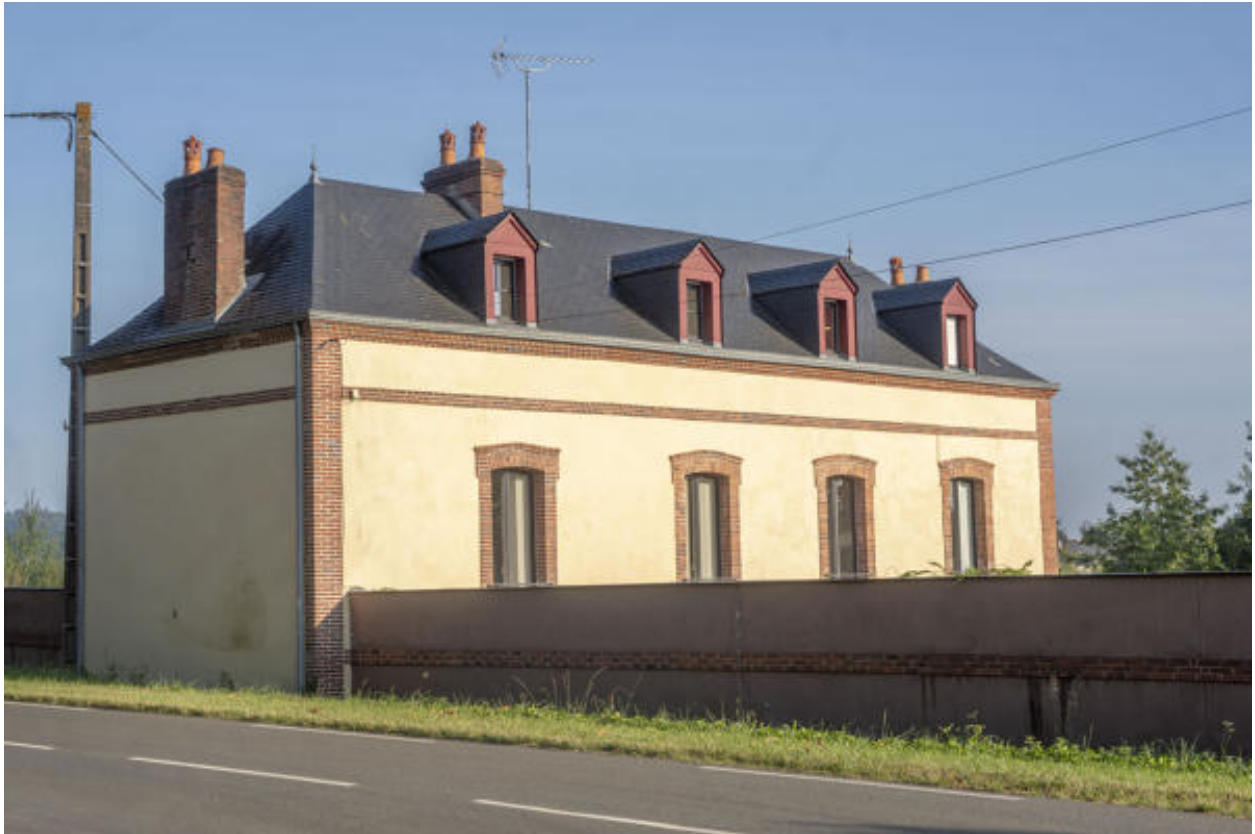
L'ancien logement patronal.
