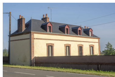
L'ancien logement patronal. Phot. Pierre-Bernard Fourny IVR52_20215301221NUCA
