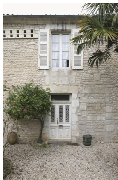
Travée principale de la façade sur cour antérieure. Phot. Patrice Giraud IVR52_20088500864NUCA
