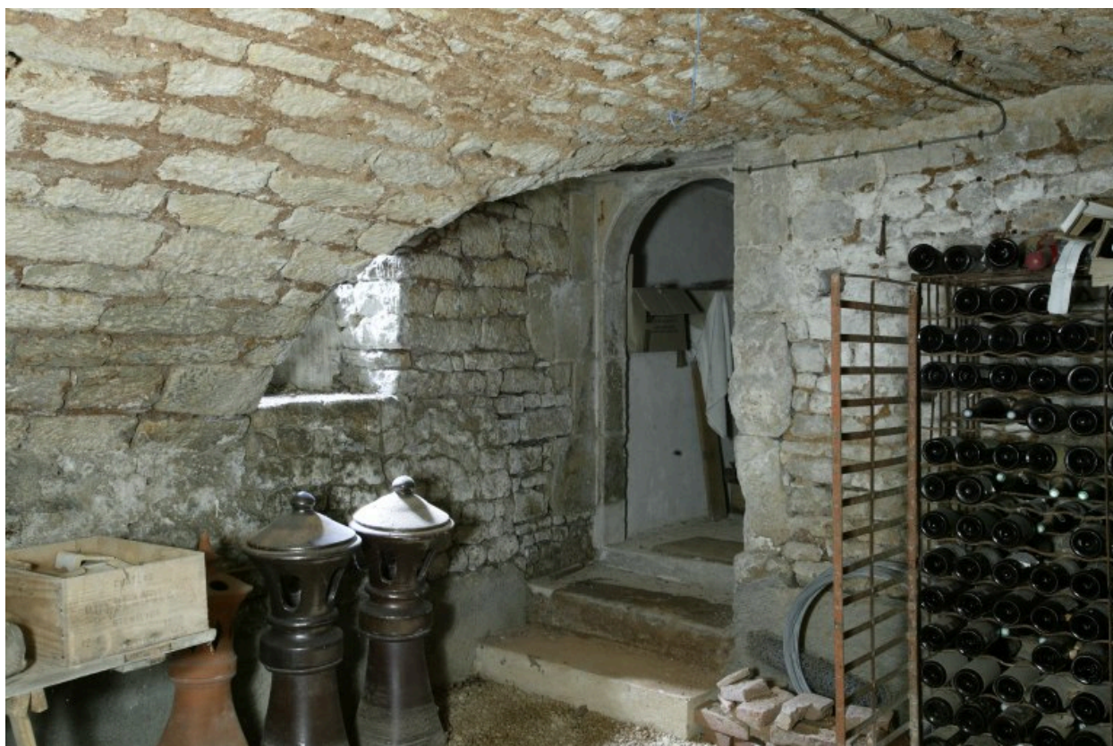
Vue du sous-sol.
