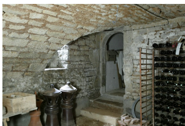
Vue du sous-sol. Phot. Patrice Giraud IVR52_20078500219NUCA
