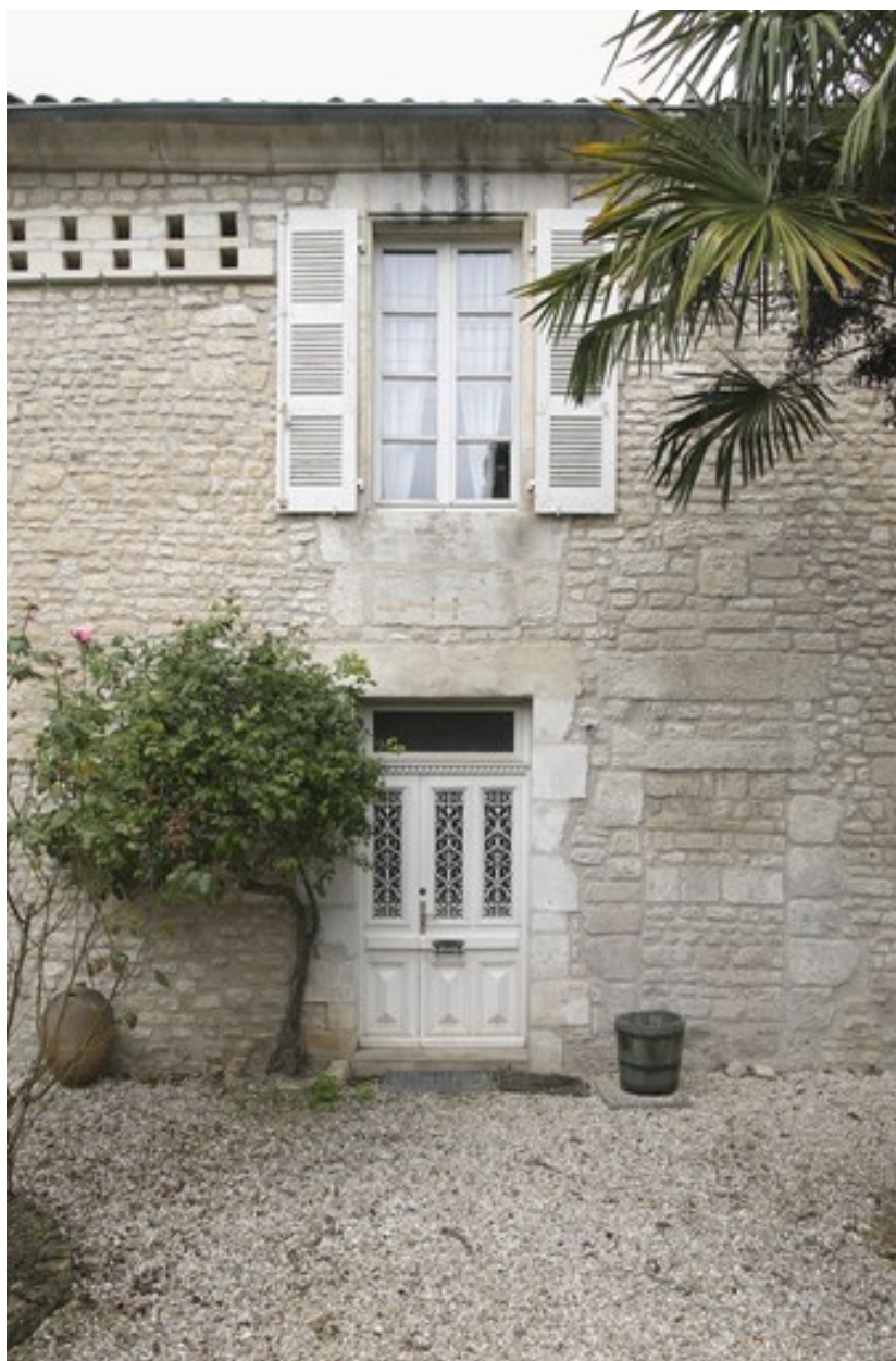
Travée principale de la façade sur cour antérieure.
