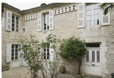
Façades donnant sur la cour antérieure. Phot. Patrice Giraud IVR52_20088500863NUCA
