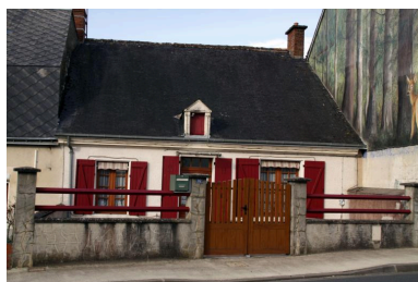
maison : 10, rue du Calvaire. Phot. Jean-Baptiste Darrasse IVR52_20107200449NUCA
