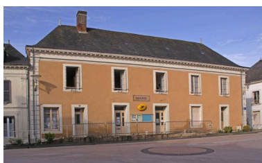
2, rue du Calvaire. Actuellement, mairie. Phot. Jean-Baptiste Darrasse IVR52_20107200456NUCA
