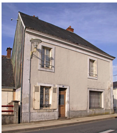
Maison : 8, rue du Calvaire. Phot. Jean-Baptiste Darrasse IVR52_20107200450NUCA
