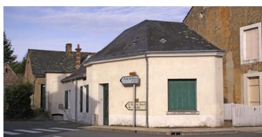
Maison : rue de la forêt. Phot. Jean-Baptiste Darrasse IVR52_20107200451NUCA
