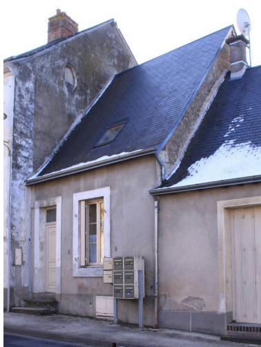
Maison : 1 bis, rue de la Fontaine. Phot. Jean-Baptiste Darrasse IVR52_20107200249NUCA
