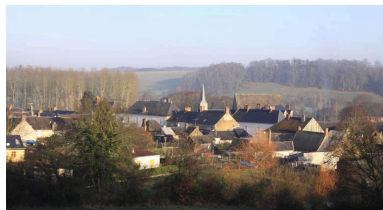
Vue prise depuis le sud. Phot. Jean-Baptiste Darrasse IVR52_20097201814NUCA
