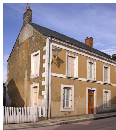
Maison : 6, rue du Calvaire. Phot. Jean-Baptiste Darrasse IVR52_20107200454NUCA
