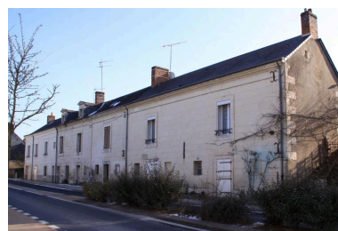
Série de maisons : 21, 23, 25 et 29 rue de la Fontaine. Phot. Jean-Baptiste Darrasse IVR52_20107200276NUCA
