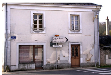
Maison : rue de la forêt. Phot. Jean-Baptiste Darrasse IVR52_20107200453NUCA
