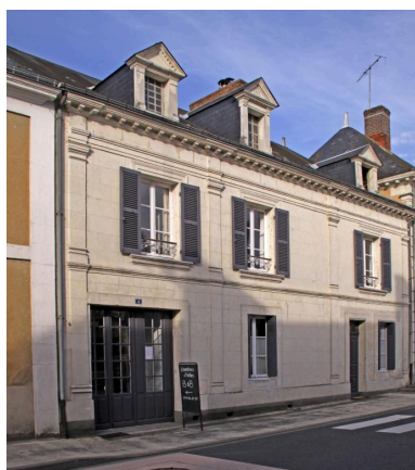
maison : 4, rue du Calvaire. Phot. Jean-Baptiste Darrasse IVR52_20107200455NUCA
