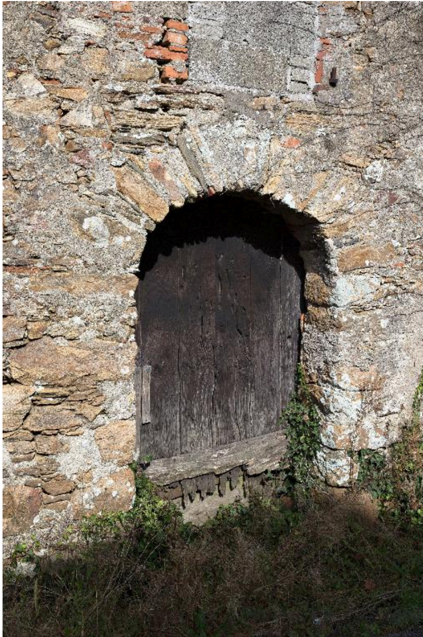
Porte plein cintre en dalles de schiste, AT01-216, cadastre 2018.
