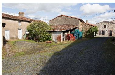
Îlot bâti, AT01-175, cadastre 2018. Phot. Denis Pillet IVR52_20154400537NUCA
