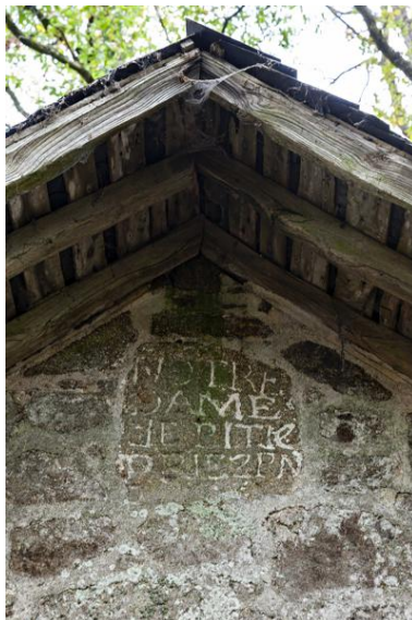
Oratoire du Boulay, inscription sur le mur-pignon nord NOTRE DAME DE PITIE PRIEZ POUR NOUS. Phot. Yves Guillotin IVR52_20205300399NUCA
