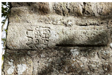
Oratoire du Boulay, remploi dans la chaîne d'angle nord-ouest de la base d'une croix médiévale portant l'inscription "Jehan de Boulay" Phot. Yves Guillotin IVR52_20205300398NUCA
