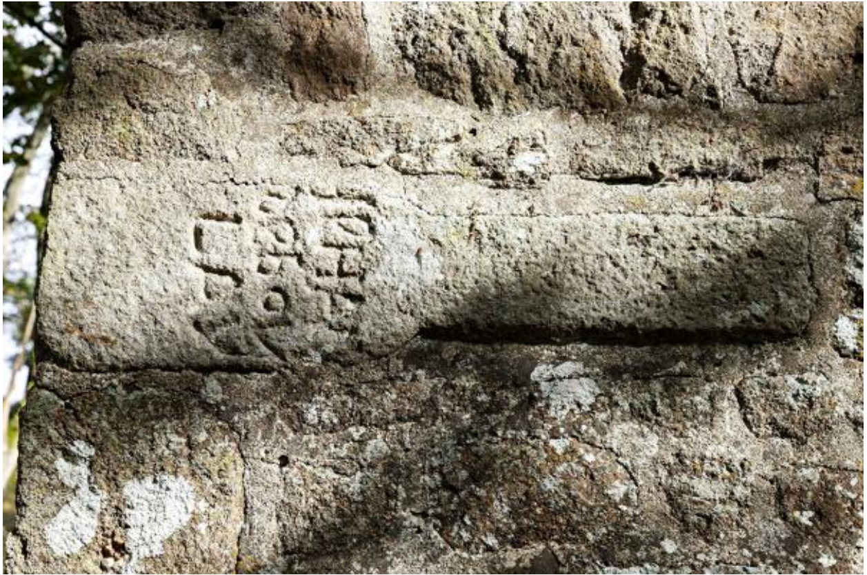
Oratoire du Boulay, remploi dans la chaîne d'angle nord-ouest de la base d'une croix médiévale portant l'inscription "Jehan de Boulay"
