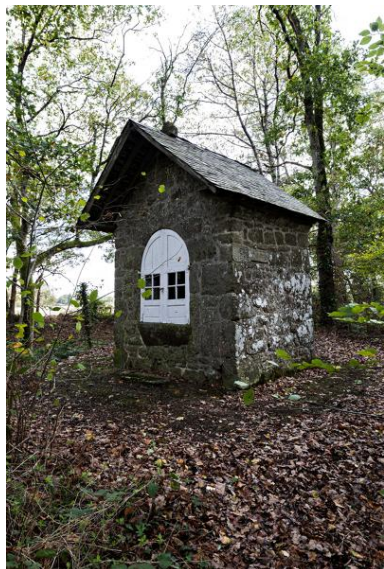
Oratoire du Boulay, vue d'ensemble. Phot. Yves Guillotin IVR52_20205300395NUCA
