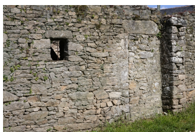
Détail des contreforts de la grange. Phot. Denis Pillet IVR52_20084401354NUCA
