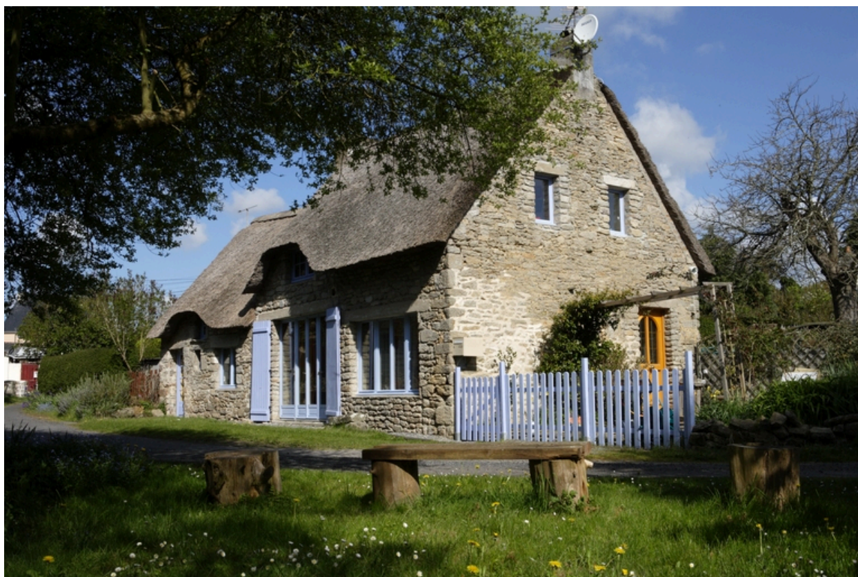
Vue d'ensemble depuis sud-est.
