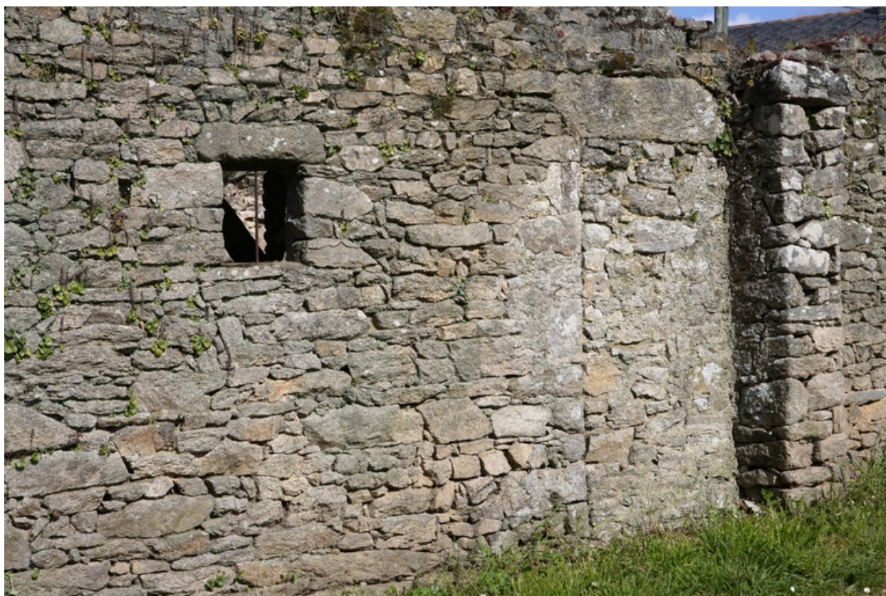
Détail des contreforts de la grange.
