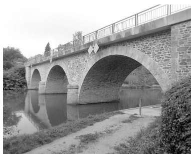
Le pont vu de la rive gauche depuis l'aval. Phot. François Lasa IVR52_20015300423X
