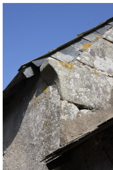
Détail du rampant se terminant par une crossette sur le pignon sud du 1er logement (1 rue des Rigadeaux). Phot. Denis Pillet IVR52_20074401362NUCA
