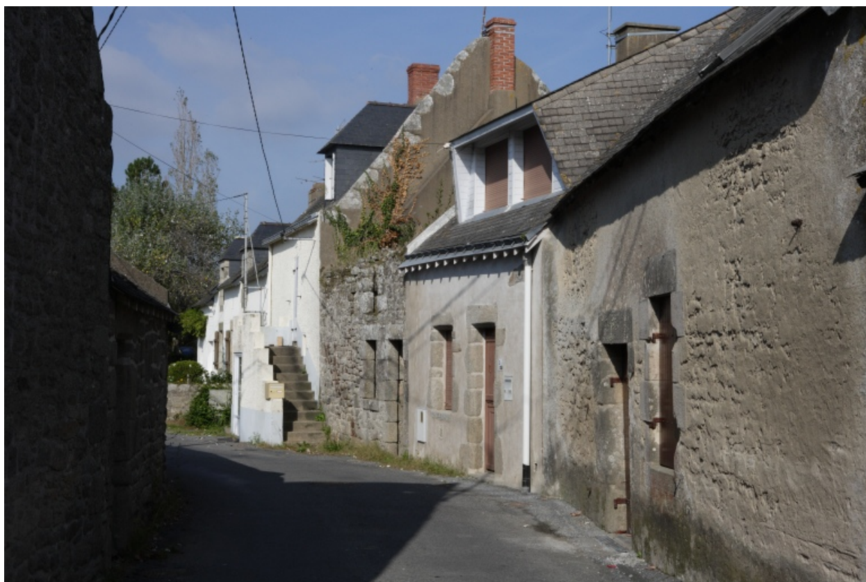
Vue de la rangée depuis le sud-ouest (1 rue des Rigadeaux ; 2, 4, 6 rue Riau).
