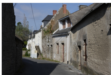
Vue de la rangée depuis le sud-ouest (1 rue des Rigadeaux ; 2, 4, 6 rue Riau). Phot. Denis Pillet IVR52_20074401360NUCA
