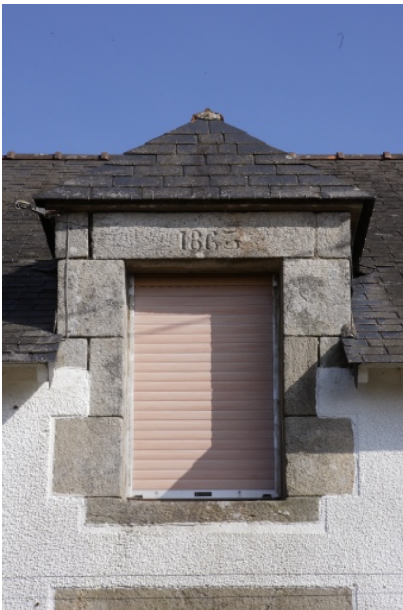
Détail de la lucarne du 5e logement (8 rue Riau) datée 1865.
