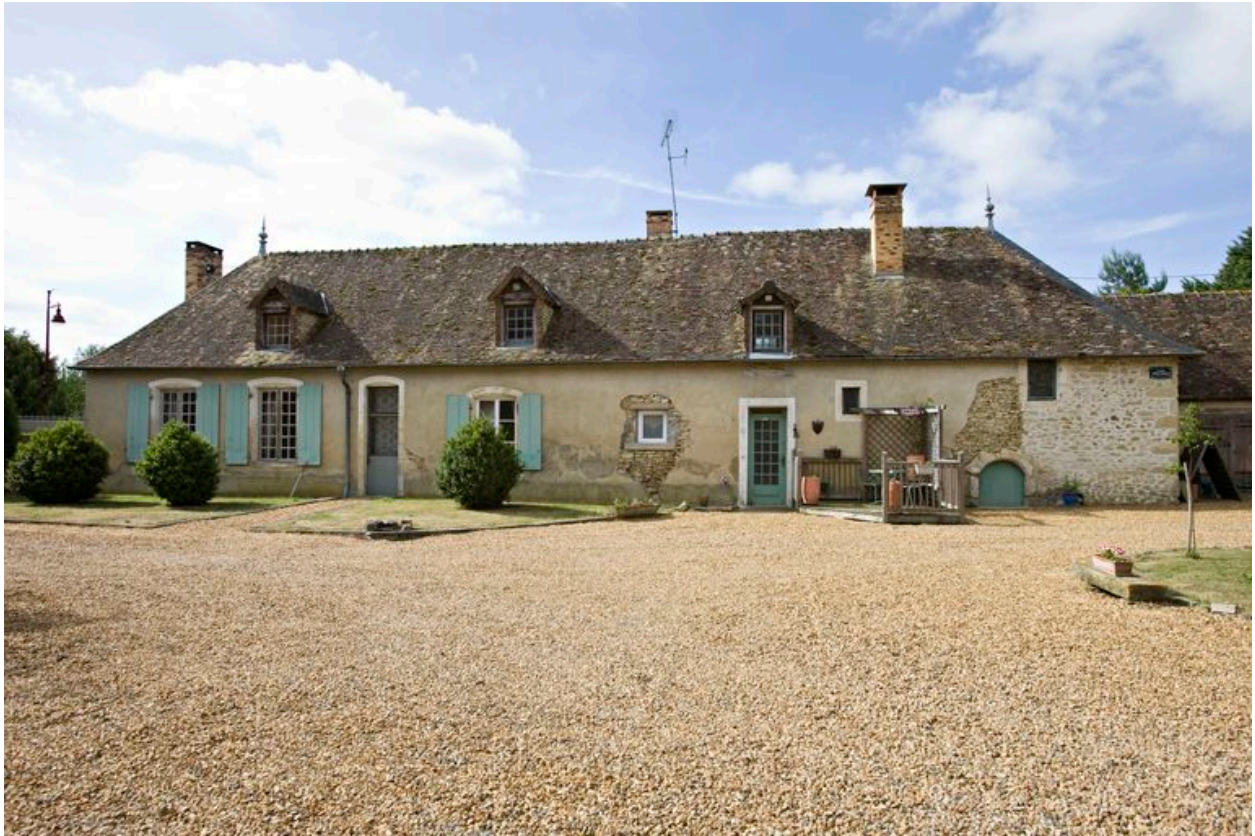
Elevation sur cour du logis
