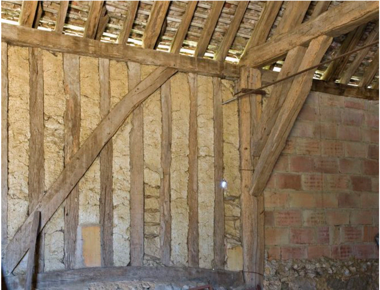
Détail de l'élévation postérieure de la grange
