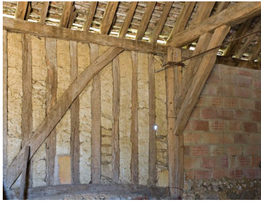
Détail de l'élévation postérieure de la grange Phot. Yves Guillotin IVR52_20117200634NUCA
