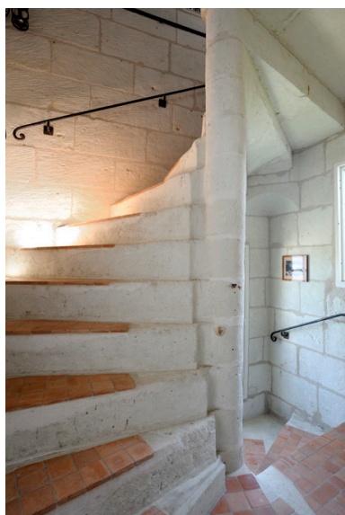
Tourelle d'escalier hors-oeuvre. Escalier en vis (remanié), avec marches à gorge au collet et marche d'angle reposant sur une trompe. Phot. Bruno Rousseau IVR52_20124901539NUCA
