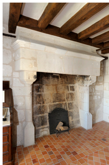
Etage, salle haute. Cheminée de la seconde moitié du XVe siècle. Phot. Bruno Rousseau IVR52_20124901538NUCA
