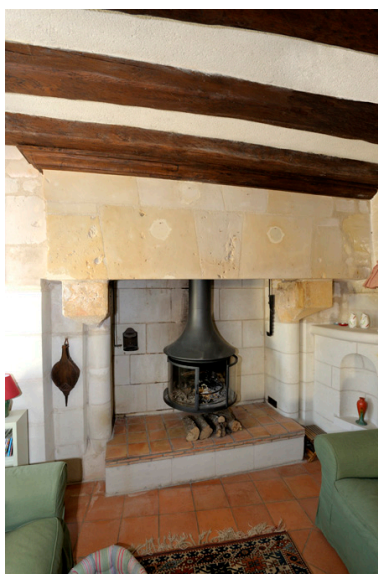
Rez-de-chaussée, salle principale. Cheminée de la seconde moitié du XVe siècle. Phot. Bruno Rousseau IVR52_20124901537NUCA
