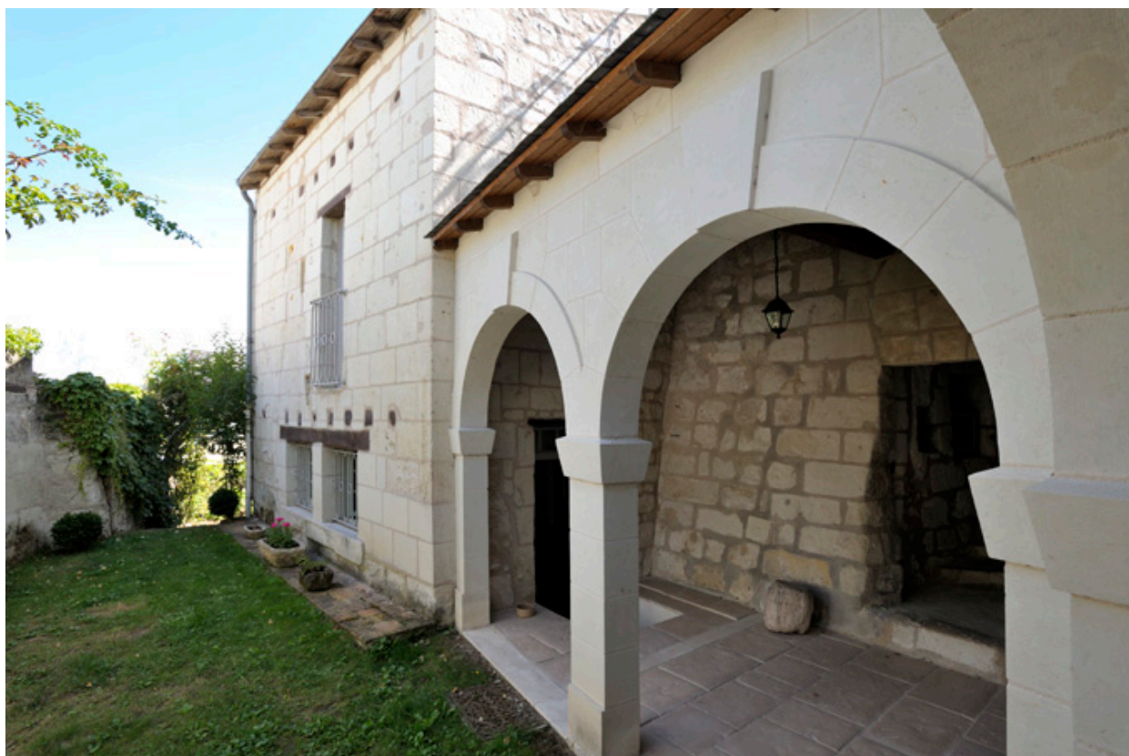
Façade nord, avec arcade récemment édiflée. En arrière-plan, abris troglodytiques (communs).
