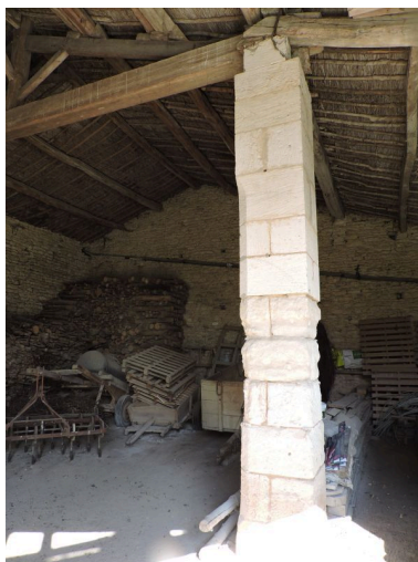
Le hangar, soutenu par un pilier en pierre de taille. Phot. Yannis Suire IVR52_20198501926NUCA
