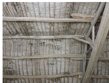
Le toit du hangar, en roseau. Phot. Yannis Suire IVR52_20198501927NUCA
