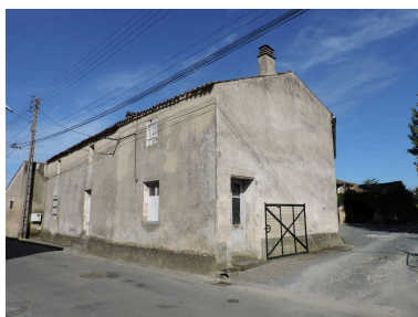
Le logis vu depuis l'est. Phot. Yannis Suire IVR52_20198501918NUCA
