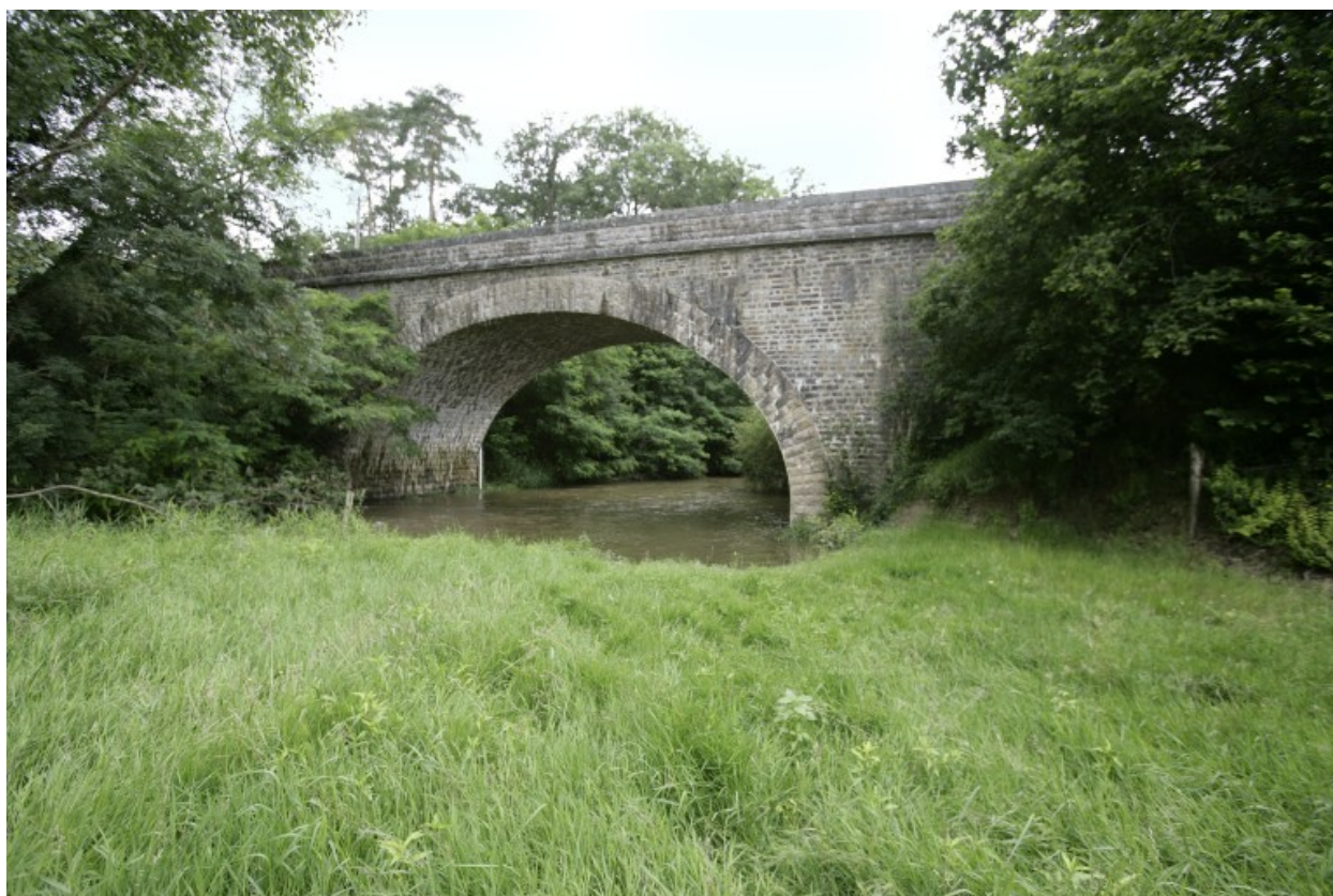
Vue d'aval depuis la rive gauche.
