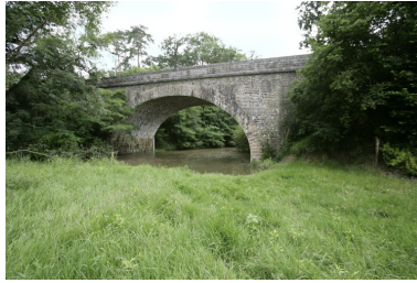
Vue d'aval depuis la rive gauche.
