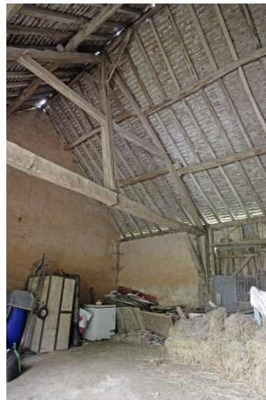
Grange-étables-remise, vue intérieure.
