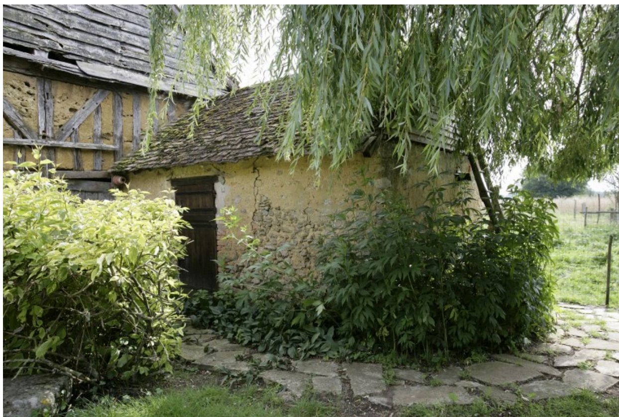
Porcherie, élévation sur cour.
