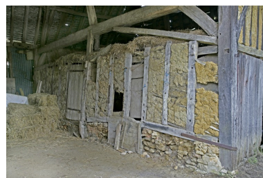
Grange-étables-remise, cloison de refend.
