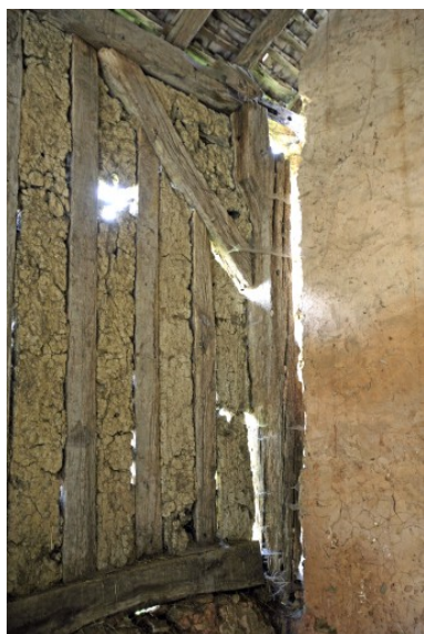
Grange-étables-remise, vue intérieure : angle sud-est.
