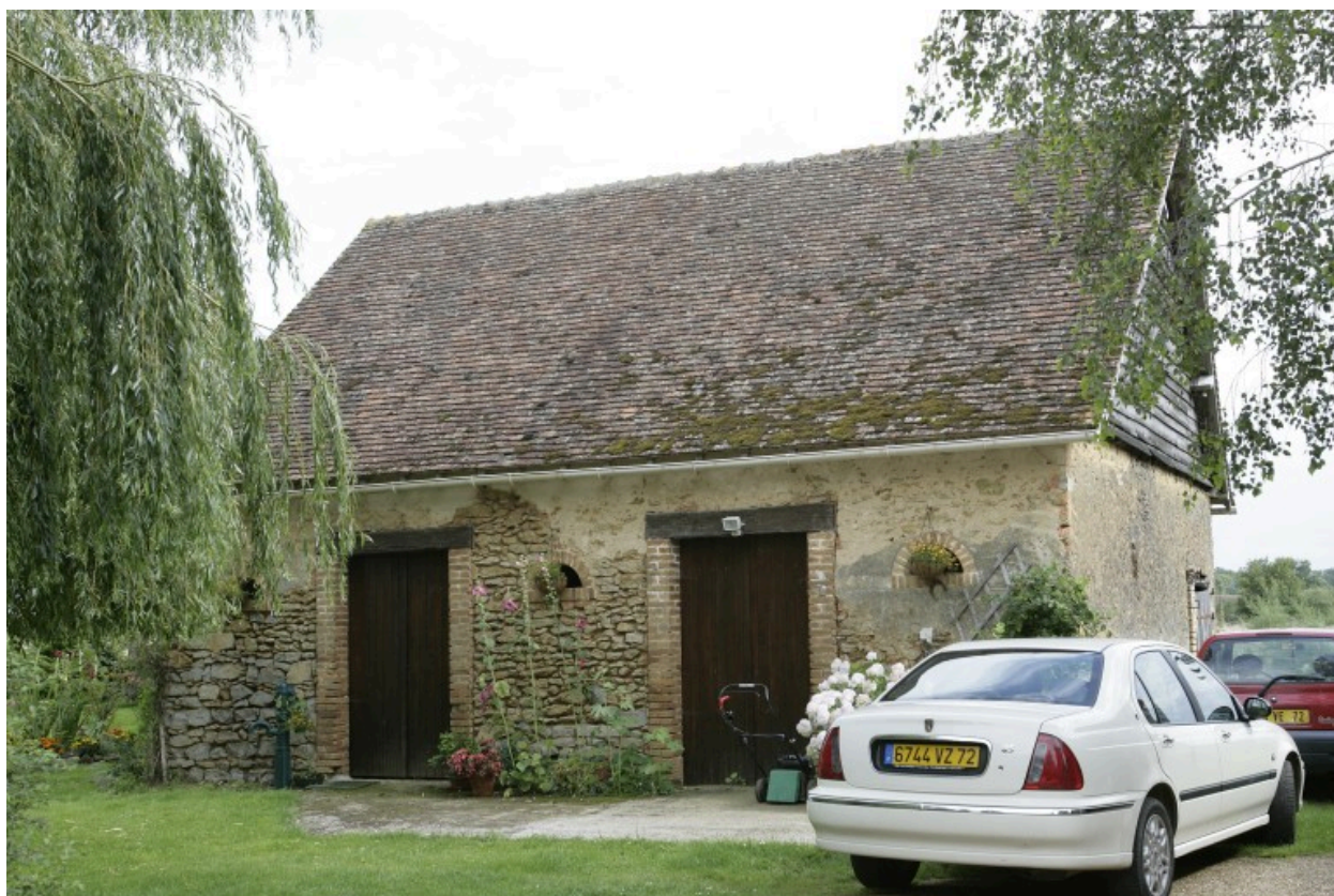
Étables, élévation sur cour.
