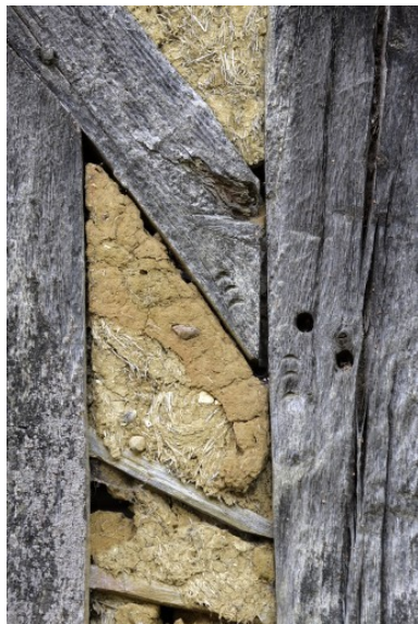
Grange-étables-remise, élévation antérieure : marques d'assemblage.
