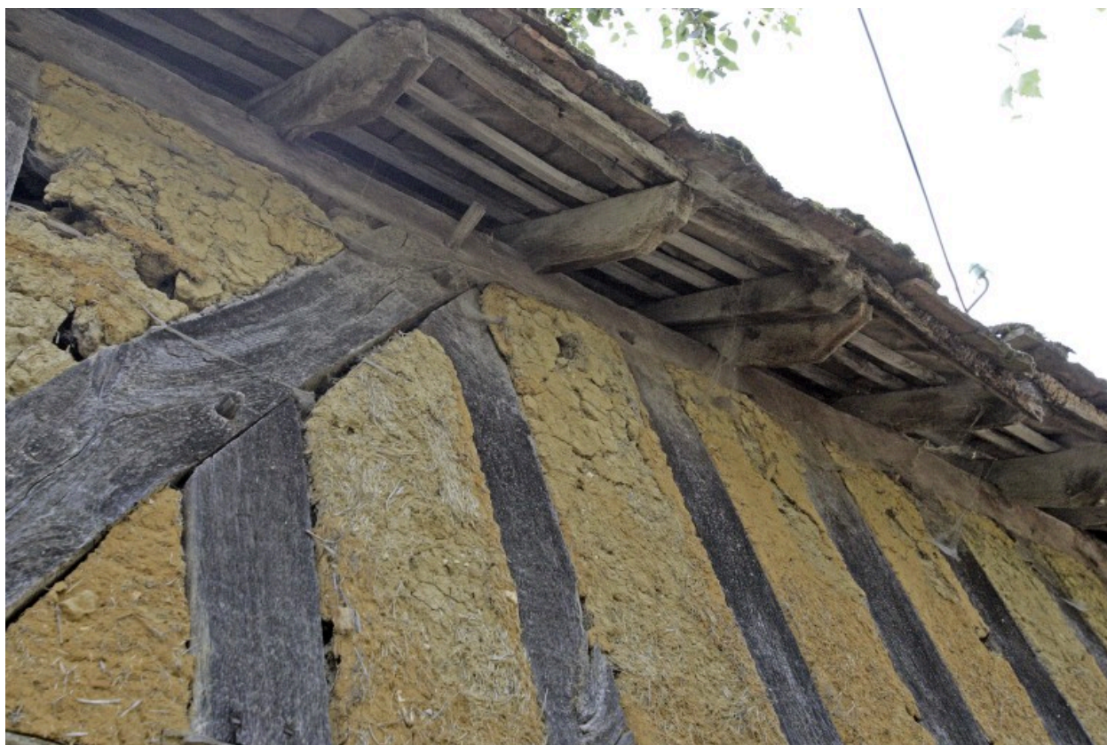
Grange-étables-remise, élévation postérieure : détail, coyaux.
