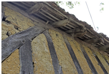
Grange-étables-remise, élévation postérieure : détail, coyaux.
