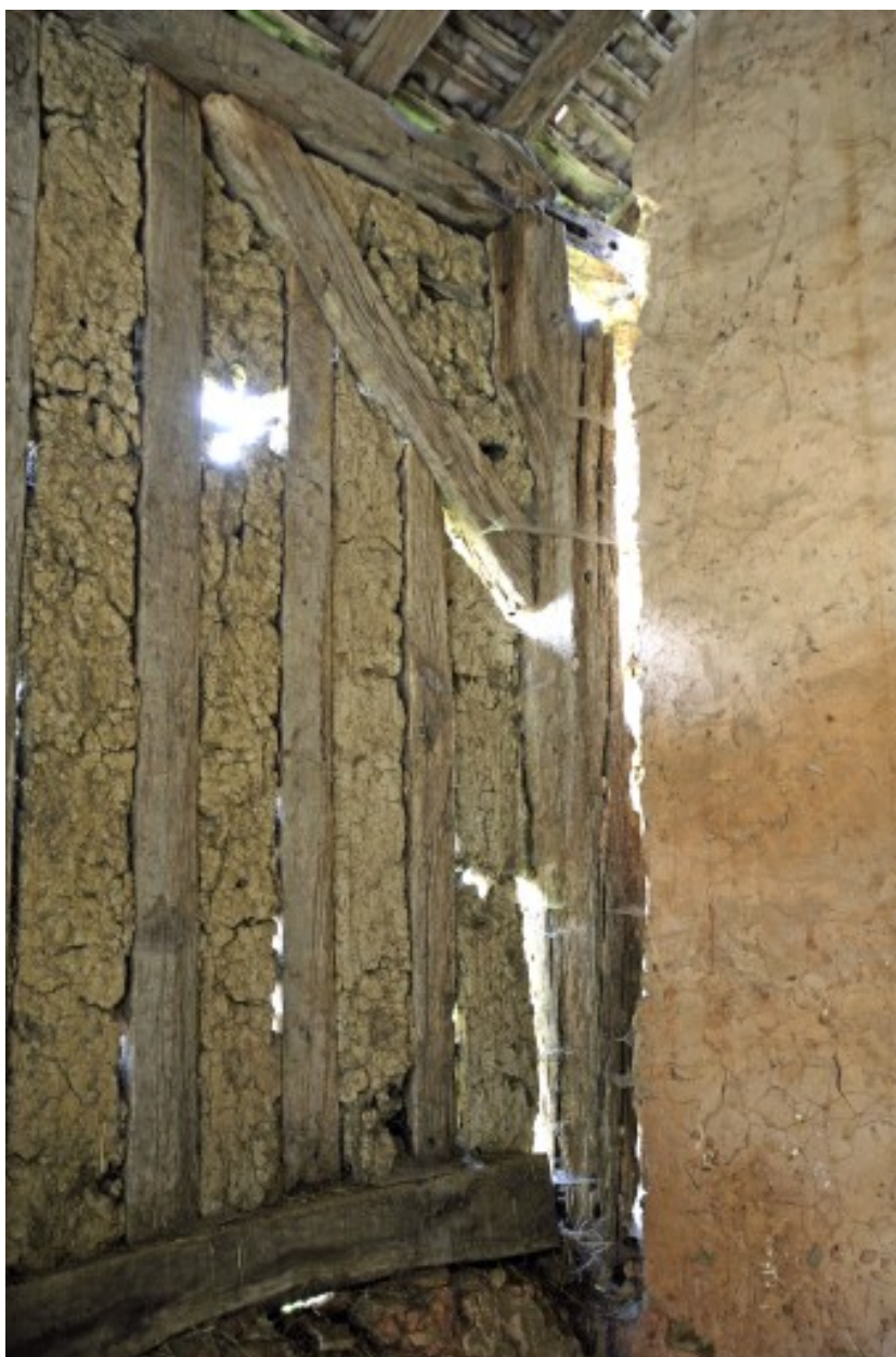
Grange-étables-remise, vue intérieure : angle sud-est.
