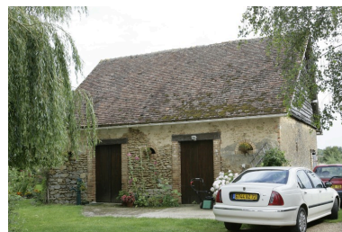
Étables, élévation sur cour.
