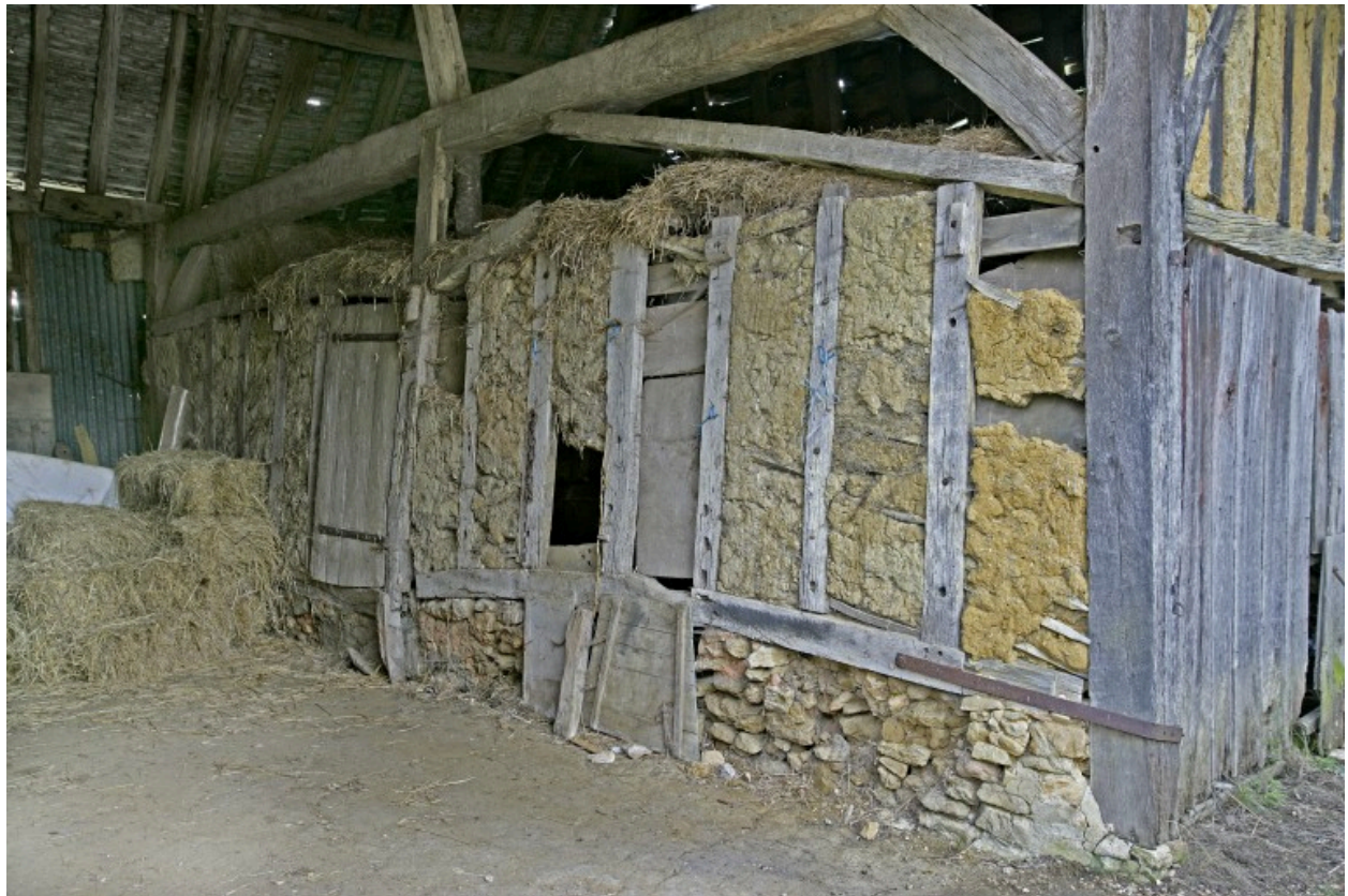
Grange-étables-remise, cloison de refend.
