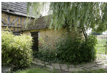
Porcheries, élévation sur cour.
