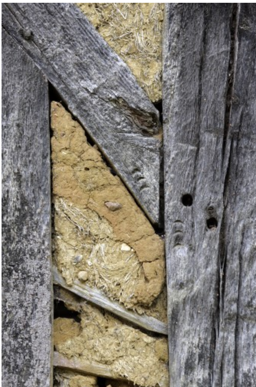
Grange-étables-remise, élévation antérieure : marques d'assemblage.
