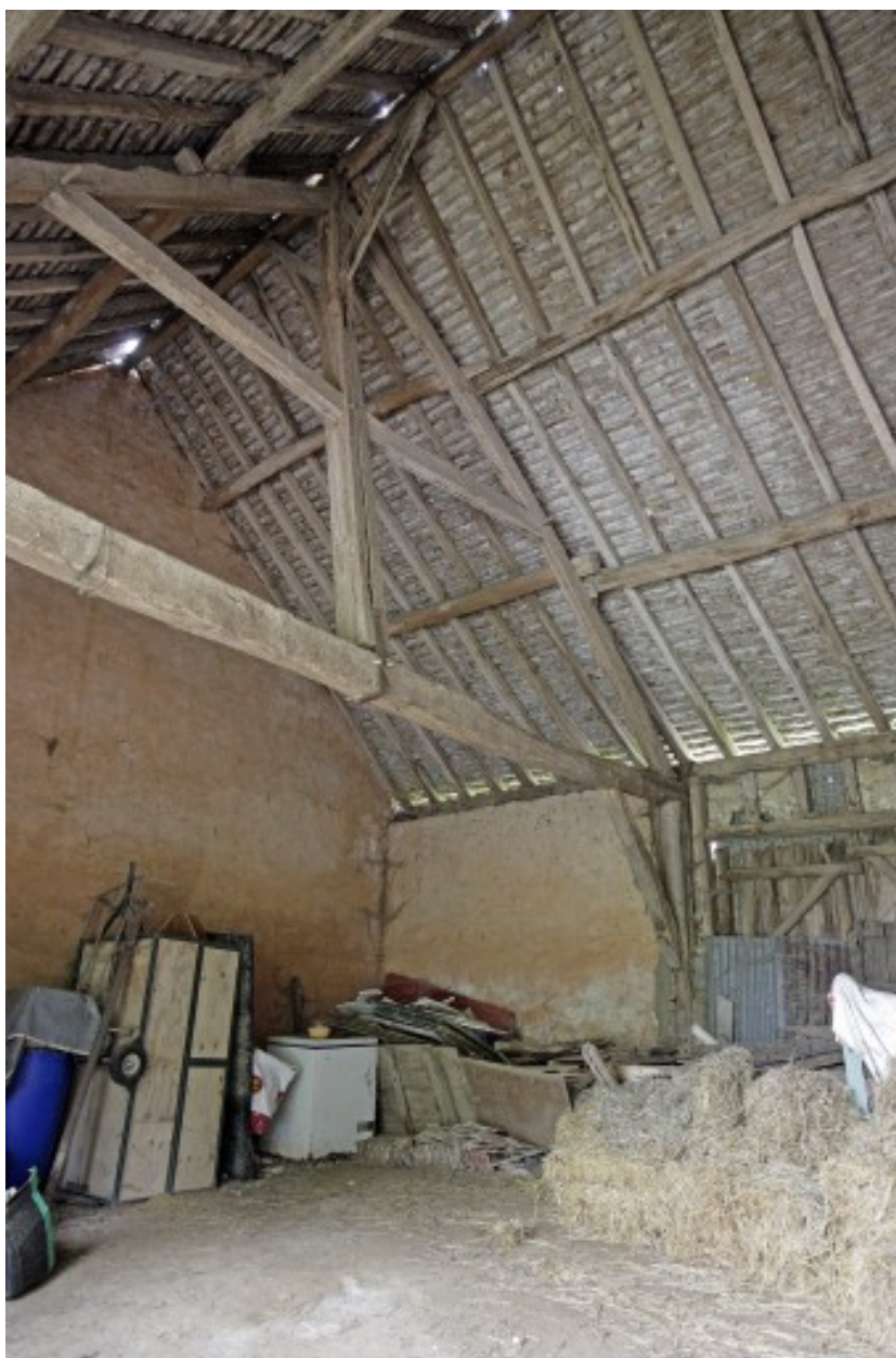
Grange-étables-remise, vue intérieure.
