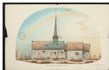
Elévation sud de l'ancienne église de Saint-Julien-du-Terroux. Repro. Morgane Acou-Le Noan IVR52_20205300563NUCA
