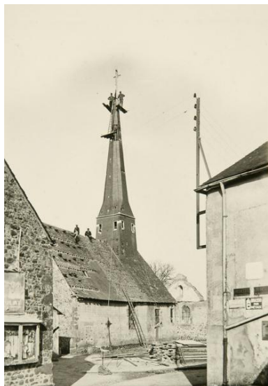
Réparation à la couverture de l'ancienne église de Saint-Julien-du-Terroux. Repro. Morgane Acou-Le Noan IVR52_20205300528NUCA
