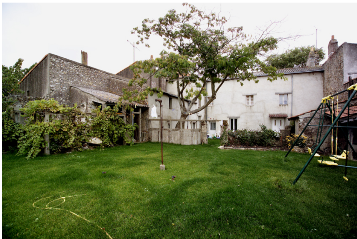
La façade postérieure vue depuis le jardin.
